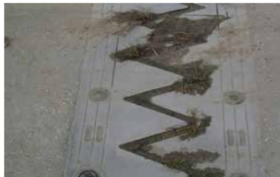
**Attention :** assurer le fonctionnement mécanique normal de l'ouvrage en permettant une liberté de mouvement adaptée aux variations dimensionnelles (effet de la température, retrait/fluage), à sa géométrie (biais, courbure) et aux déplacements induits par les sollicitations sous trafic, sous l'effet du freinage et de l'action de la force centrifuge, en garantissant une continuité de la surface de circulation.
