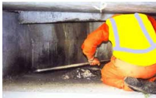
**Attention :** la plupart des anciens ouvrages sont mal conçus et les conditions d'accès aux sommiers sont difficiles. Une reconnaissance préalable et une réflexion sur les moyens d'accès et les dispositifs de sécurité sont nécessaires.
