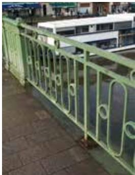
**Fonctions :** permet d'éviter la chute des piétons et autres modes doux de déplacement, mais n'est pas en capacité de retenir les véhicules. Les prescriptions techniques auxquelles doit répondre le garde-corps sont indiquées dans la norme NF P98-405. On peut également consulter le guide Sétra Garde-corps – Collection du guide technique GC, avril 1997, Cerema.
