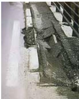
**Fonction :** les trottoirs permettent la circulation des piétons, contiennent éventuellement des réseaux, les bordures servent de fil d'eau et évitent que les véhicules ne franchissent le trottoir.
