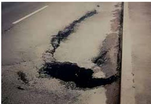
La chaussée d'un pont à tablier est constituée d'un revêtement en béton bitumineux mince, mis en œuvre sur la chape d'étanchéité. Celle-ci garantit le bon état du tablier de l'ouvrage. Il est impératif d'éviter la moindre détérioration de la chape ; si une atteinte y a été portée, elle doit être confirmée par l'inspection d'un spécialiste en ouvrages d'art, pouvant être complétée par des investigations complémentaires pour faire procéder à la réparation par une entreprise spécialisée.
