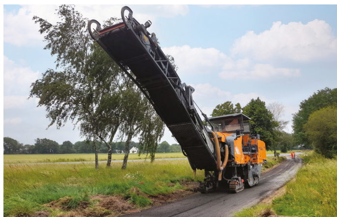
Figure 4-9 : Phase déconstruction (Cerema)
