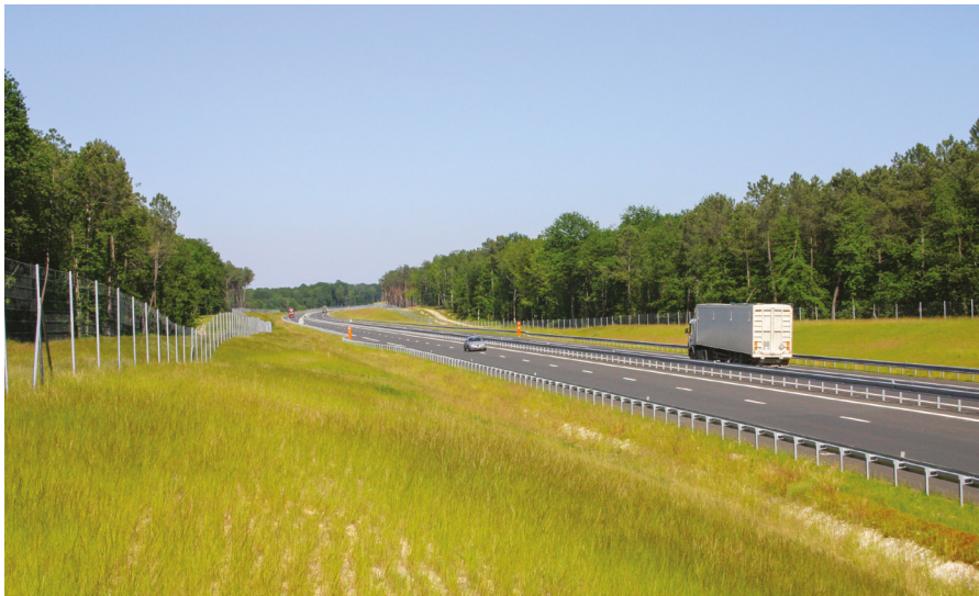
Figure 3-17 : Dépendance verte en cours de végétalisation (Cerema)
