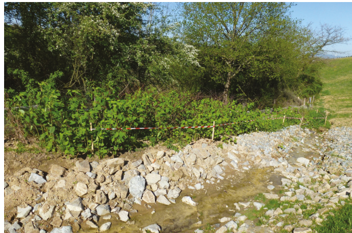
Figure 4-8 : Phase travaux : balisage (J. Biaunier/Cerema)
