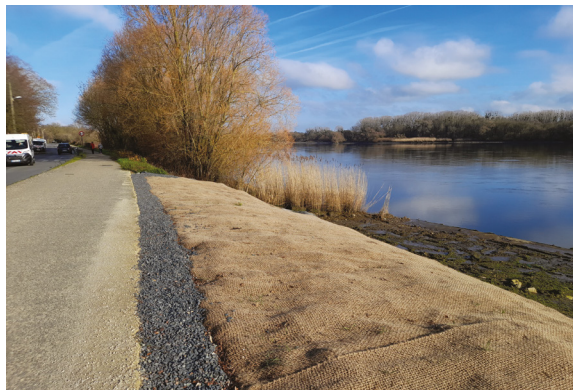
Figure 5-47 : Bâchage végétal ou dégradable renouées (travaux VNF avec accompagnement du CEN Pays de la Loire (Cerema))
