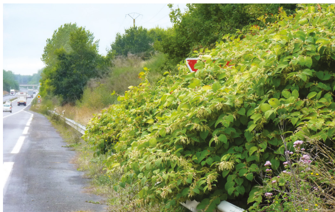
Figure 3-1 : Renouées asiatiques présentes le long des ILT et occasionnant des gênes de visibilité des panneaux de signalisation (Cerema)
