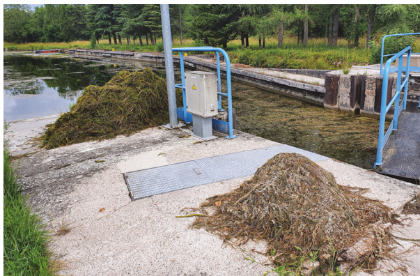
Figure 5-59 : Stockage intermédiaire, ressuyages végétaux aquatiques (VNF)
