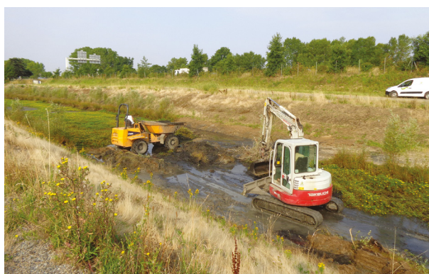
Figure 5-56 : Gestion par exportation de la jussie dans un bassin d'assainissement routier (Cerema)
