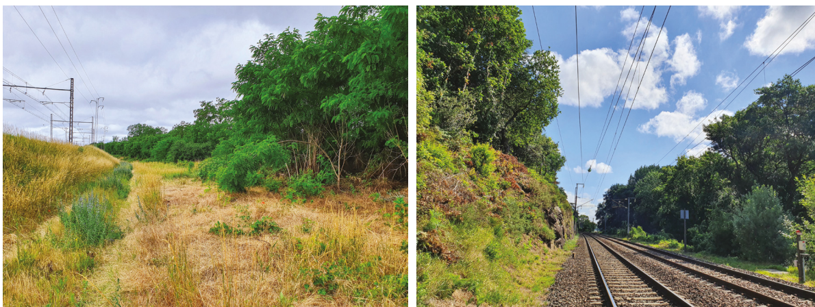
Figure 3-16 : Dépendances ferroviaires (SNCF Réseau)
