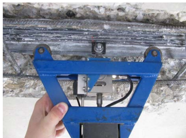
Figure 16b : Mesure de tension sur un fil de précontrainte par « arbalète »
