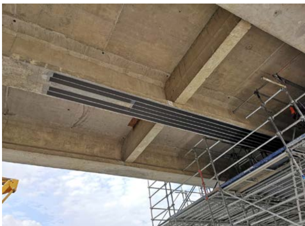
Figure 3 : La réalisation d'une réparation efficace constitue l'achèvement d'un processus rigoureux de diagnostic et d'études. Ici, le renforcement d'un VIPP avec des lamelles et des tissus de fibres de carbone collés.
