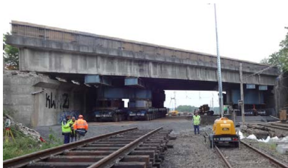
Figure 24 : Fig. 22b – Enlèvement d'un pont par porteur multi-essieux pendulaires
