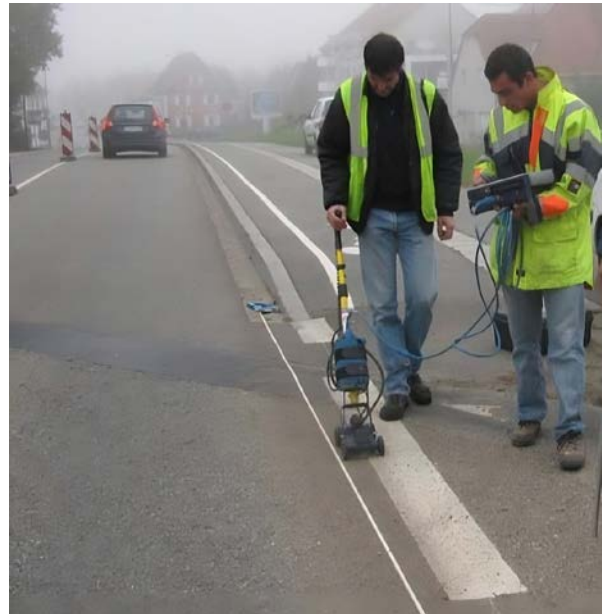
Figure 15b : Investigations radar sur chaussée : essai non destructif facilement réalisable
