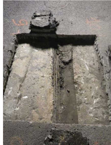
Figure 6 : Ouverture de fenêtre en chaussée pour reconnaissance
