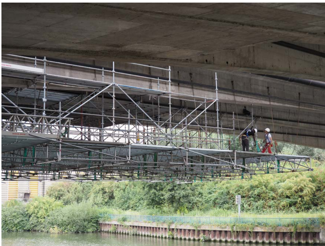
Figure 25a : accès à l'ouvrage suspendu sur une demi-passe navigable
