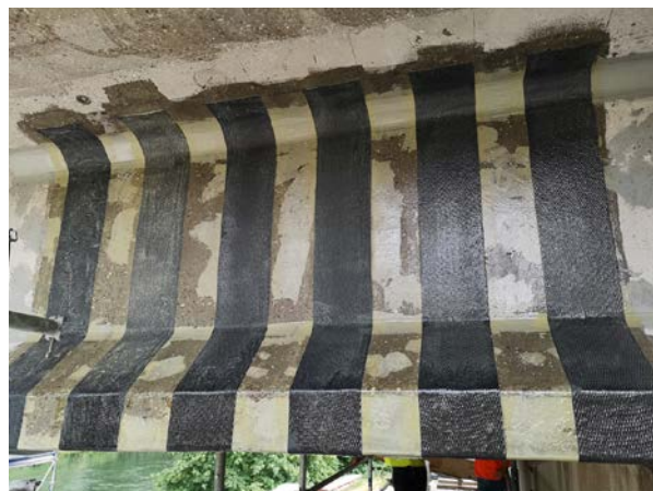
Figure 3 : La réalisation d'une réparation efficace constitue l'achèvement d'un processus rigoureux de diagnostic et d'études. Ici, le renforcement d'un VIPP avec des lamelles et des tissus de fibres de carbone collés.
