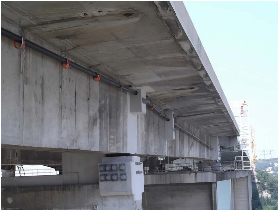
Figure 1 : Réparation du viaduc de Martigues sur la passe de Caronte par précontrainte additionnelle (DIR Méditerranée)
