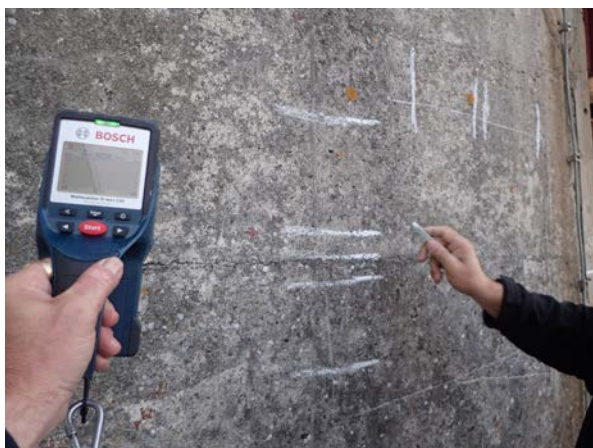
Figure 16a : Repérage d'armatures
