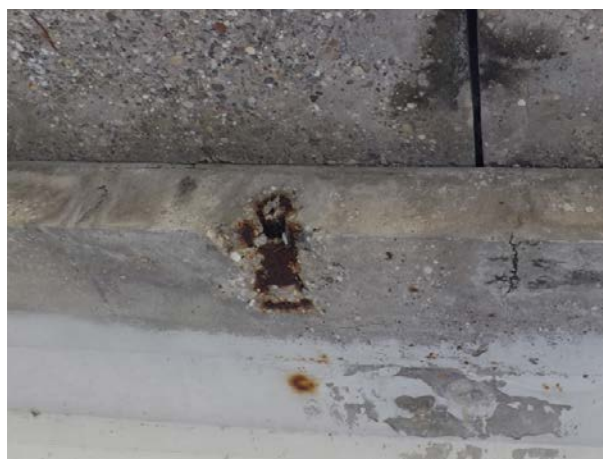
Figure 10 : VIPP : Faits générateurs : conduite d'une étude de risque. Découverte d'une étanchéité défectueuse et de la corrosion des têtes d'ancrage de câbles transversaux.
