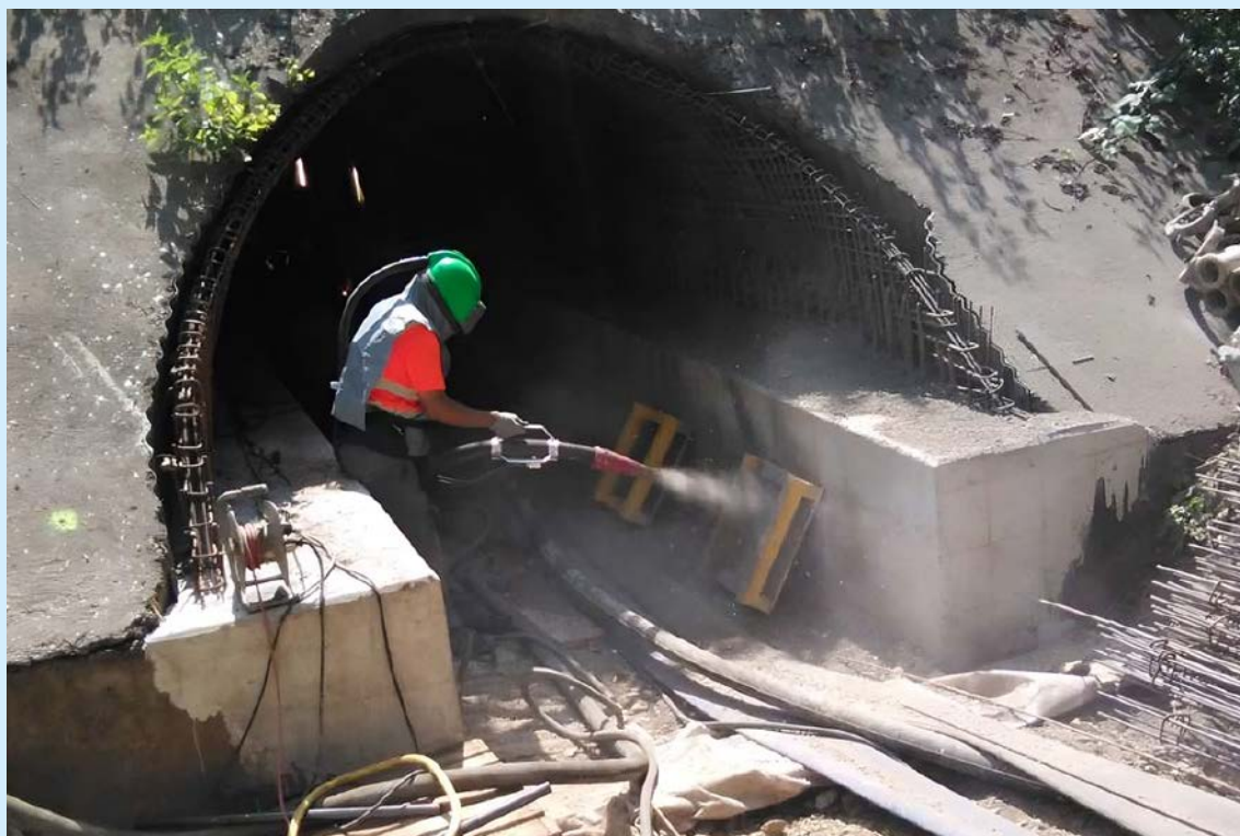
Figure 13 : Les contrôles en phase travaux : une autre condition de réussite
