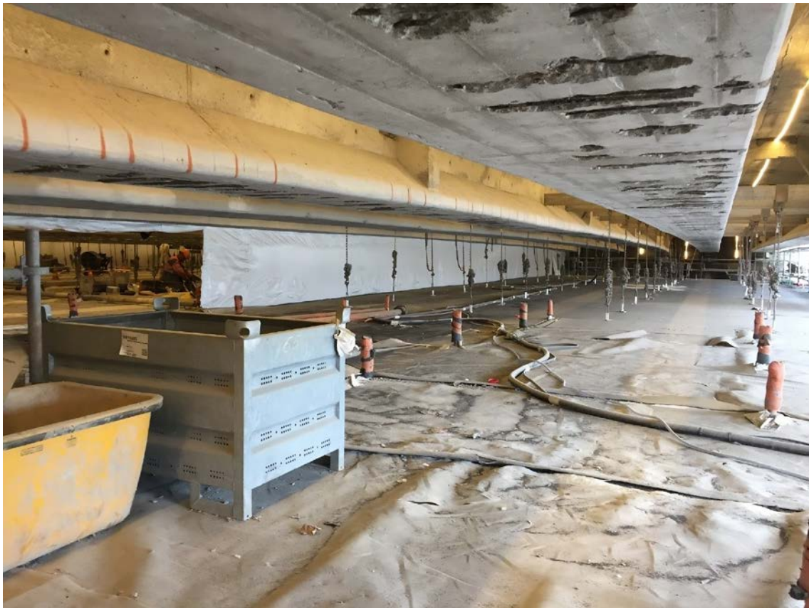
Figure 25b : platelage suspendu sous un VIPP
