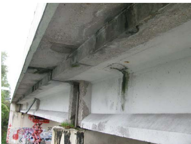
Figure 10 : VIPP : Faits générateurs : conduite d'une étude de risque. Découverte d'une étanchéité défectueuse et de la corrosion des têtes d'ancrage de câbles transversaux.
