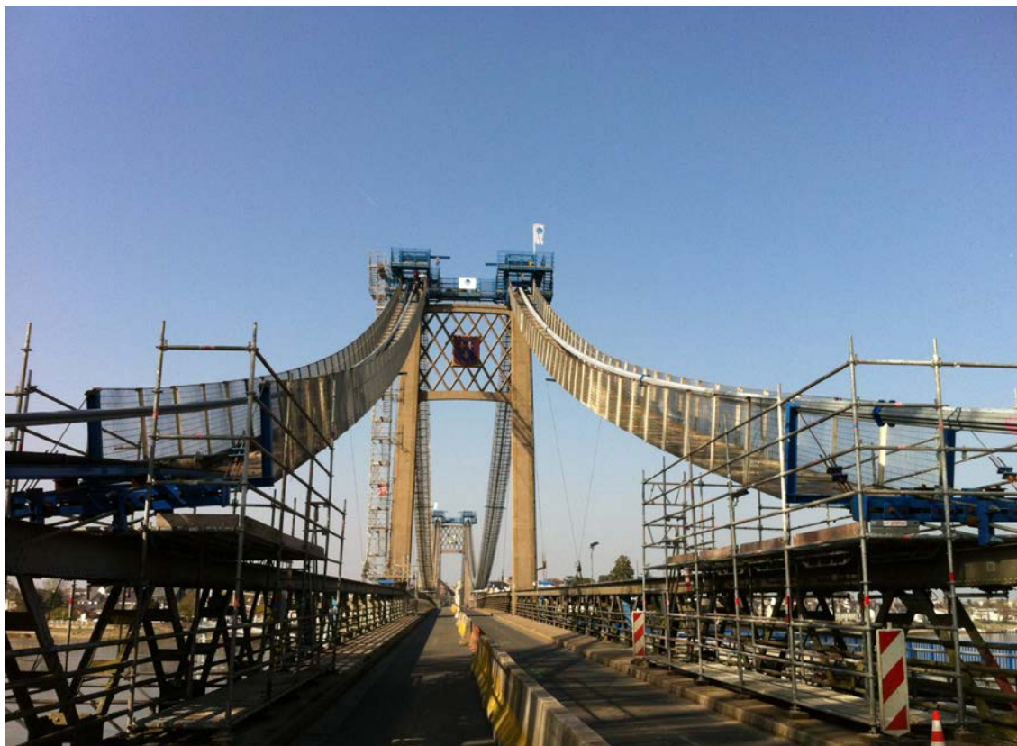
Figure 27 : phase travaux : l'aboutissement des processus d'expertises et d'études
