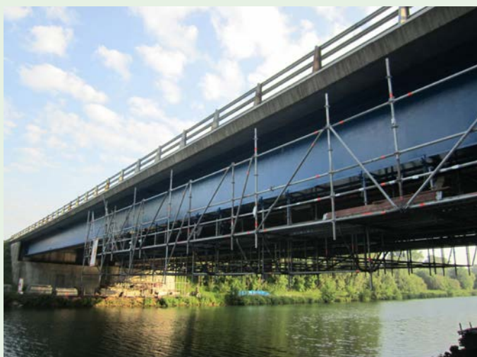
Figure 12 : Remise en peinture d'un ouvrage métallique
