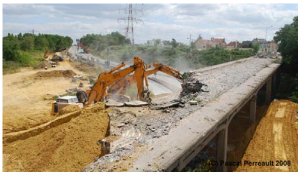
Figure 23 : Fig. 22a – Démolition d'un pont au brise-roche hydraulique (BRH)
