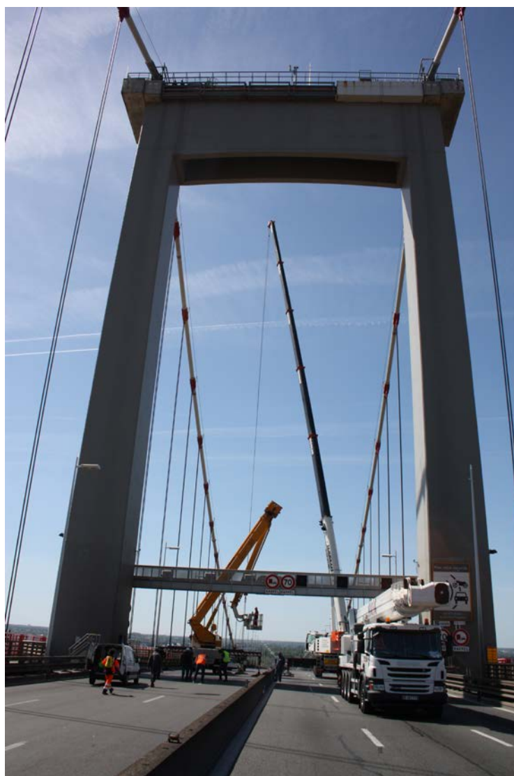
Figure 20 : Fermeture d'un ouvrage en phase de travaux dans les deux sens de circulation
