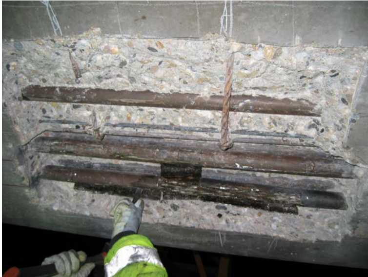
Figure 5 : Ouverture de fenêtre en intrados sur un ouvrage précontraint
