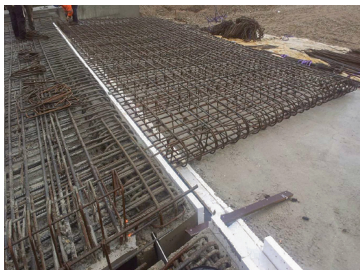
Figure 3-62 : Exemple de réalisation récente en France (rocade sud de Strasbourg OA34, culées semi-intégrales – 2016) – Ferrailage du hourdis du pont mixte et ferrailage de la dalle de transition
