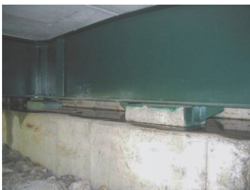
Figure 4-22 : Exemples de butées transversales sur culée – 1
