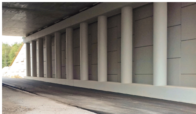
Figure 1-31 : Appui composé d'une palée de poteaux avec nervure visible (passage à faune du Tillet) (source : DIR Nord)
