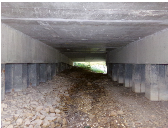
Figure 3-67 : Ouvrage de franchissement de la Vaire à Fère-Champenoise (51) avec palplanches encastrées dans le tablier (crédit : DIR Est)
