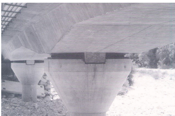
Figure 4-25 : Exemples de butées transversales sur piles – 1
