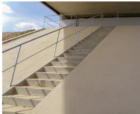
Figure 3-52 : Aménagement de l'accès à la culée d'un ouvrage sur la RN2 à Ormoy-le-Davien (60) : escalier, replat avec station debout possible pour les visites et garde-corps
