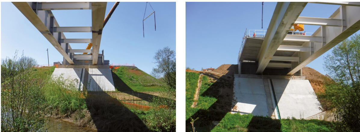
Figure 3-40 : Culée perchée du viaduc de l'Anille (72)
