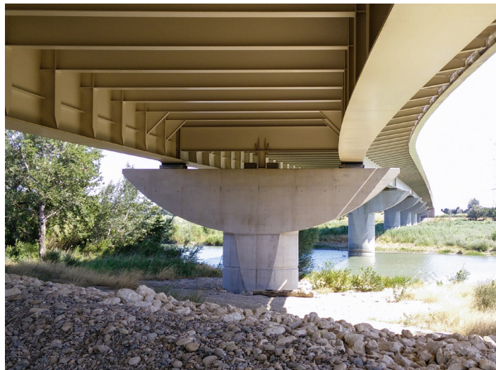
Figure 2-48 : Piles du viaduc sur la Durance aval (84)
