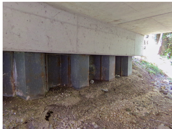
Figure 3-67 : Ouvrage de franchissement de la Vaire à Fère-Champenoise (51) avec palplanches encastrées dans le tablier (crédit : DIR Est)
