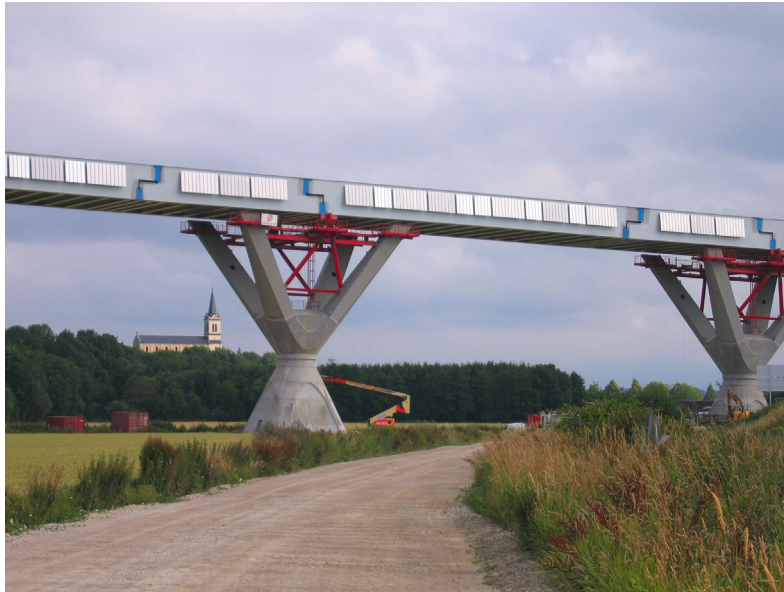
Figure 2-41 : Piles du viaduc de la Savoureuse (90)
