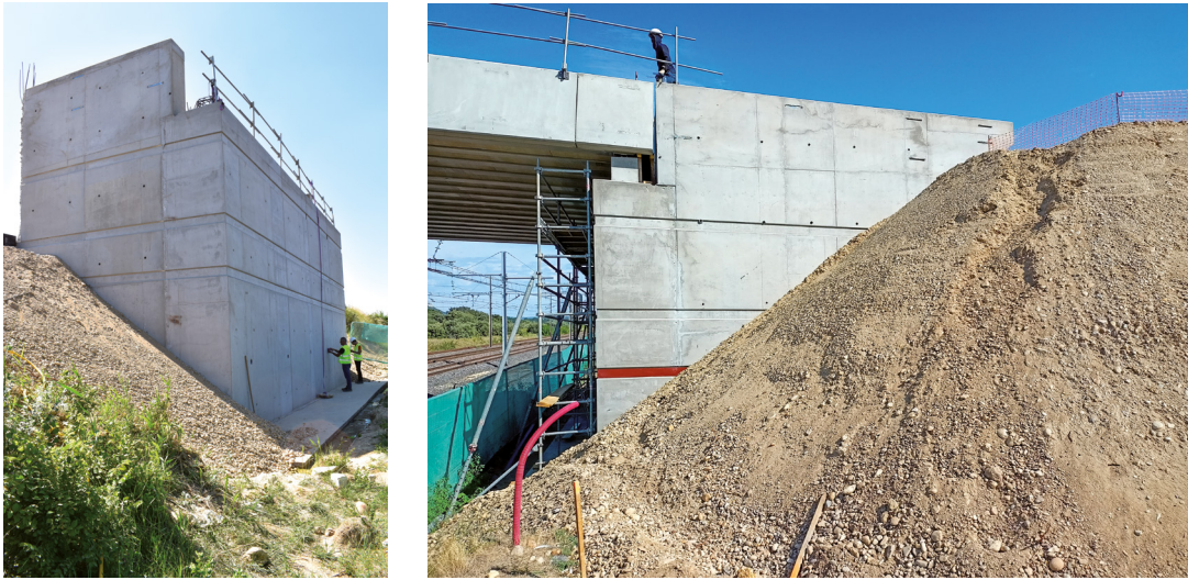
Figure 3-45 : Culées à mur de front de l'OA1 à Laudun-L'Ardoise (30)
