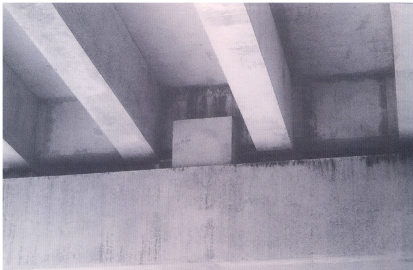
Figure 4-21 : Exemple de butée longitudinale sur culée
