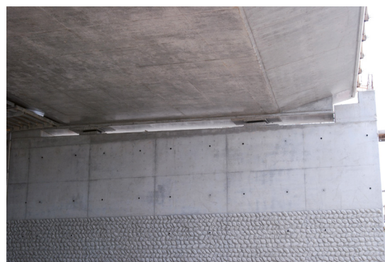
Figure 4-23 : Exemples de butées transversales sur culée – 2
