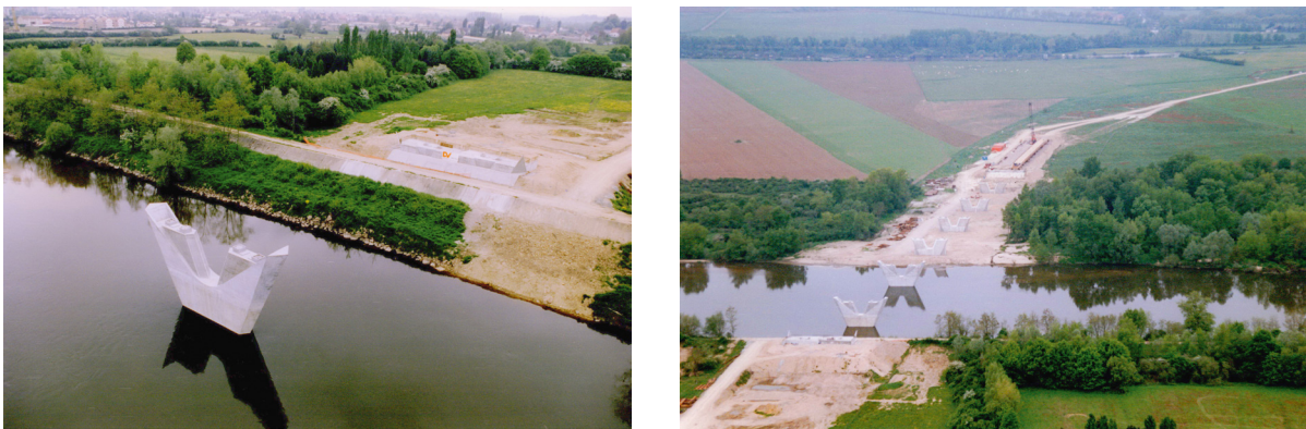
Figure 1-7 : Appuis du pont Pierre Bérégovoy à Nevers (58)
