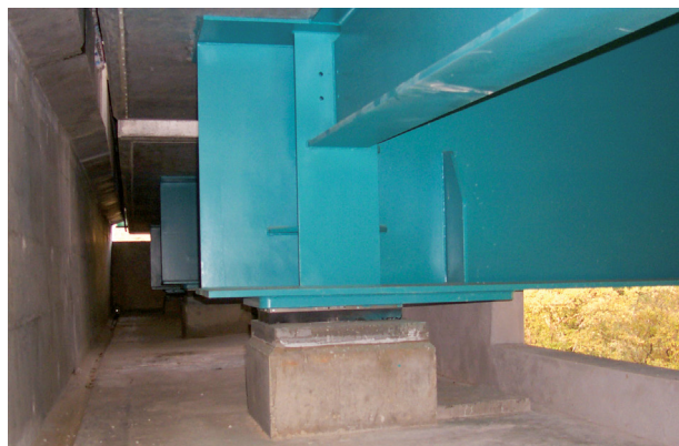
Figure 3-33 : About du viaduc de l'Hyrome sur l'A87 à hauteur de Chemillé (49) – un espace très important est réservé derrière la poutre métallique, ce qui facilite son entretien et sa durabilité
