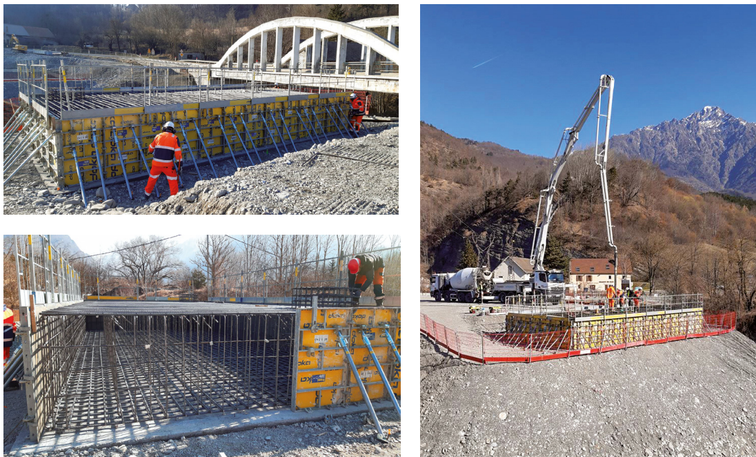
Figure 3-13 : Culée perchée fondée superficiellement sur le pont provisoire des Richards (05) (source : DIR Med)
