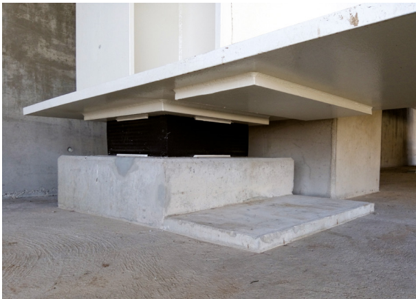
Figure 4-2 : Bossages de vérinage accolés aux bossages de service (à gauche le viaduc de Miramas, à droite l'OA29 à Peyrolles)
