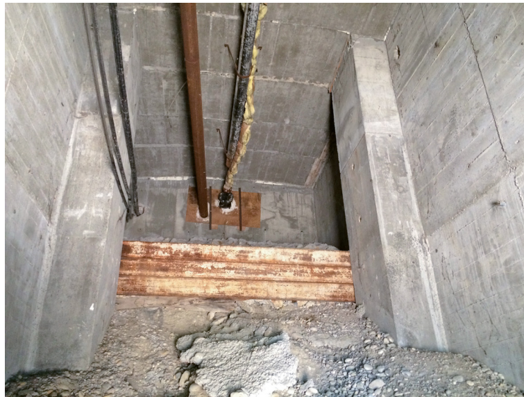
Figure 3-61 : Vue de l'intérieur d'une culée creuse sur le pont de la RD780 à Villeneuve-lez-Avignon
