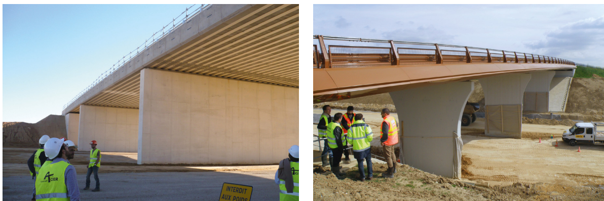
Figure 2-7 : Utilisation de voiles pour les piles intermédiaires. À gauche pont sur le contournement de Nîmes, à droite ouvrage sur la RN2 à Ormoy-le-Davien (60)
