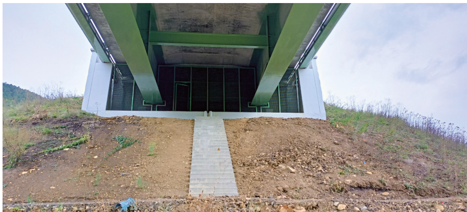
Figure 3-43 : Culée perchée du viaduc du Lot à Mende (48)
