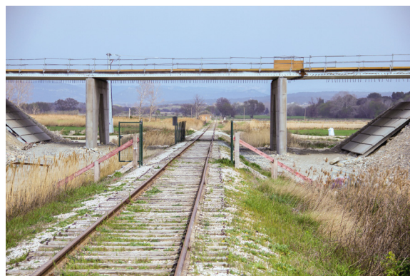
Figure 1-6 : Franchissement de voie ferrée par la rocade nord d'Arles
