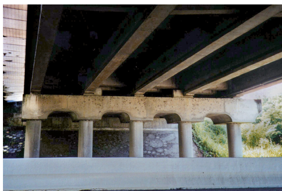
Figure 4-26 : Exemples de butées transversales sur piles – 2
