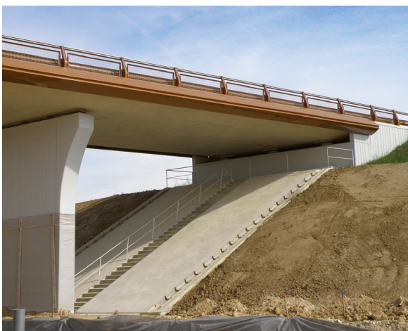
Figure 3-52 : Aménagement de l'accès à la culée d'un ouvrage sur la RN2 à Ormoy-le-Davien (60) : escalier, replat avec station debout possible pour les visites et garde-corps
