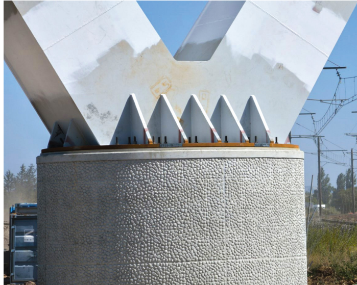
Figure 1-45 : Pile d'un des ouvrages de la déviation de Miramas – Exemple d'un parement matricé
