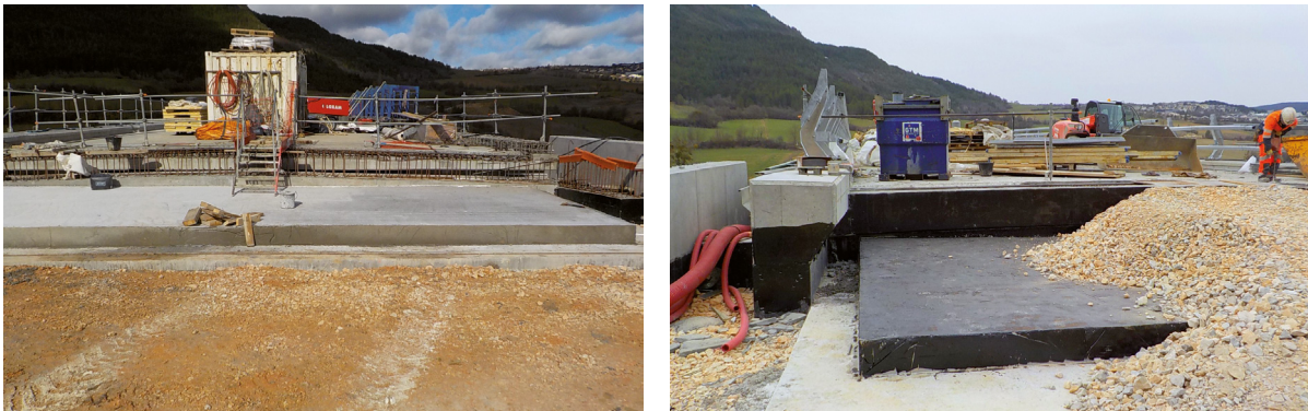
Figure 3-58 : Dalle de transition du viaduc du Lot à Mende (48) (crédit : DIR Med)
