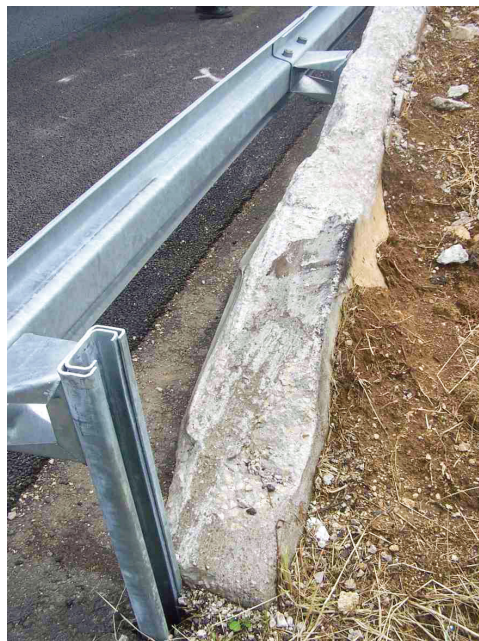
Figure 1-38 : GBA après franchissement
