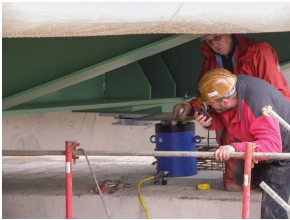
Figure 4-11 : Mise sur appuis définitifs (ouvrage de Clamarais)
