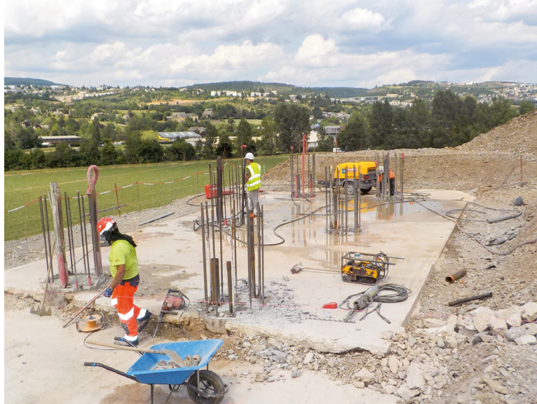
Figure 3-18 : Pieux recépés de la culée du viaduc du Lot (Mende, 2021) (source : DIR Med)
