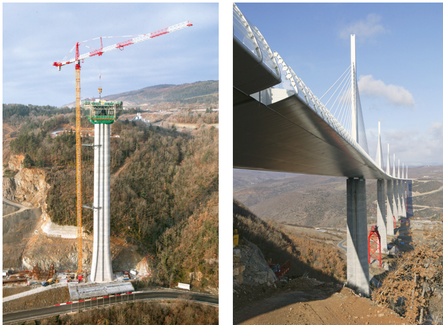
Figure 2-40 : Piles de grande hauteur – viaduc de La Colagne et viaduc de Millau
