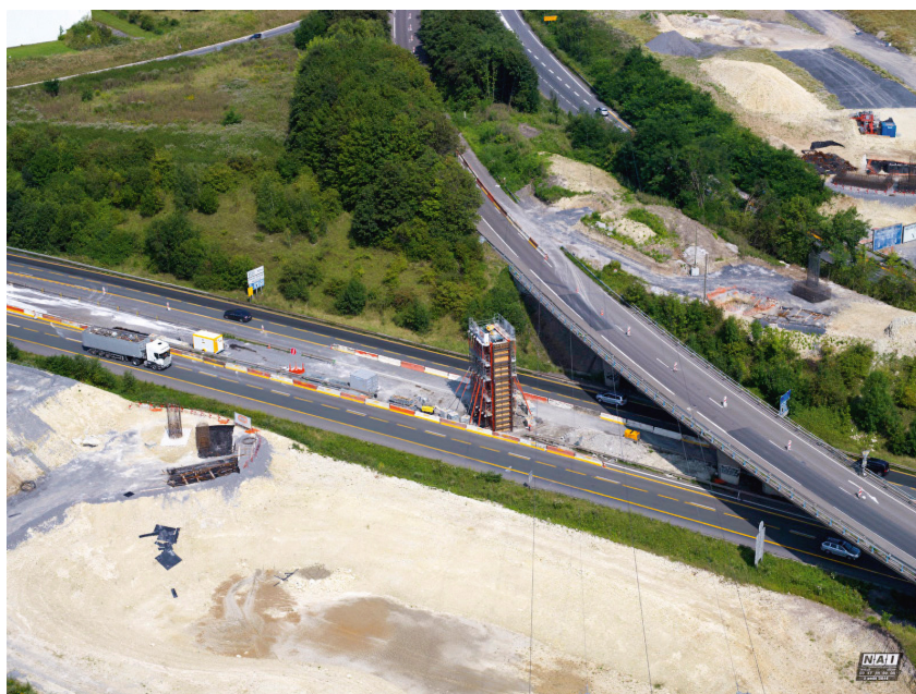
Figure 1-9 : Construction de la pile en TPC de l'autoroute A2 pour le viaduc de l'échangeur A2/A23 à La Sentinelle (59) (source : NAI)
