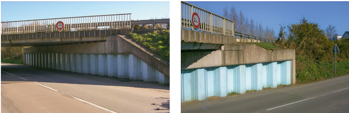
Figure 3-69 : Ouvrage sur palplanches muni d'appareils d'appui sur la D365 à Quimper
