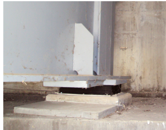
Figure 4-2 : Bossages de vérinage accolés aux bossages de service (à gauche le viaduc de Miramas, à droite l'OA29 à Peyrolles)
