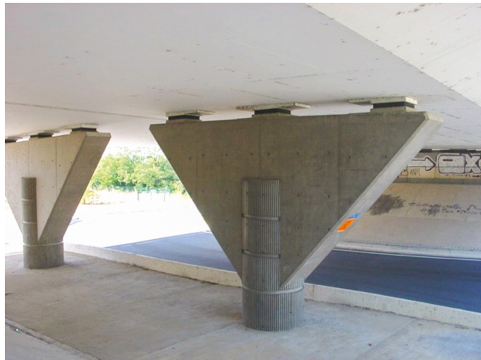
Figure 2-45 : Piles du pont sur la RD 982 à Nozières-Boucoiran
