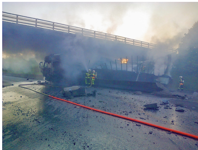
Figure 1-40 : Séparateur en béton armé détruit lors du choc (à droite sur la photo) (source : DIR NO)
