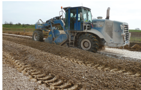
Photographies 18 et 19: Malaxeur à arbre horizontal garantissant une épaisseur de couche de sol traité constante pouvant atteindre 0,35 m avec une finesse de mouture remarquable (Source : SCSNE)
