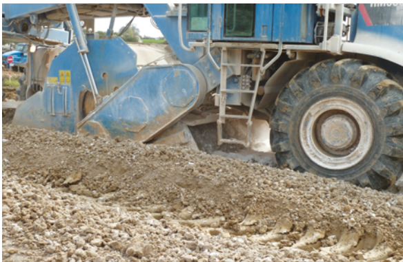
Photographies 18 et 19: Malaxeur à arbre horizontal garantissant une épaisseur de couche de sol traité constante pouvant atteindre 0,35 m avec une finesse de mouture remarquable (Source : SCSNE)
