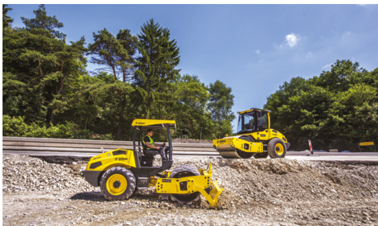
Photographie 25: Compacteur vibrant à pieds dameurs en premier plan, compacteur vibrant à cylindre lisse au second plan (Source: BOMAG)
