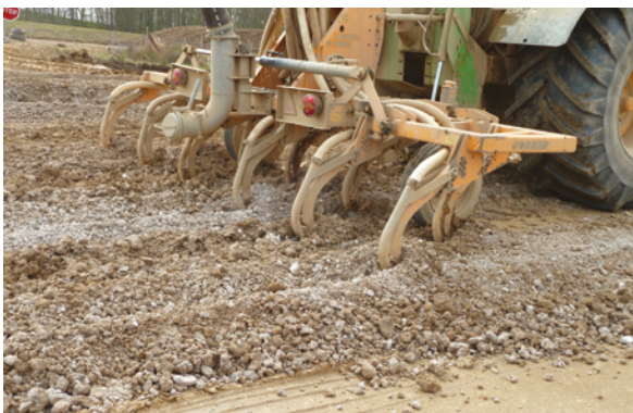
Photographies 14 et 15 : Humidification par enfouisseuse (Source : SCSNE)
