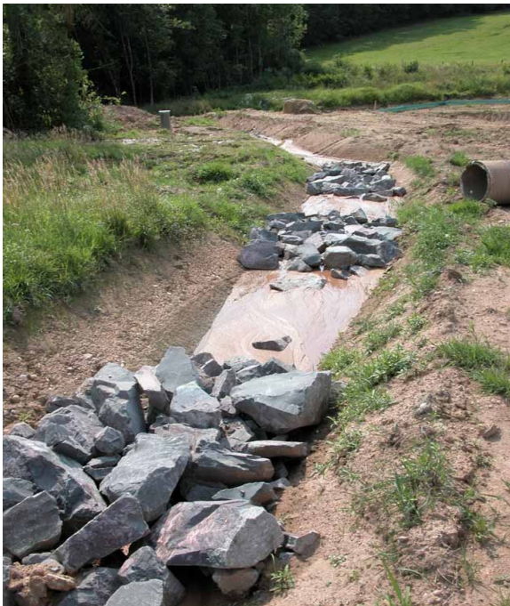
Illustration 10 - Fossés de collecte des eaux de chantier, avec dispositif de réduction de la vitesse (blocs en cascade) pour les fortes pentes
