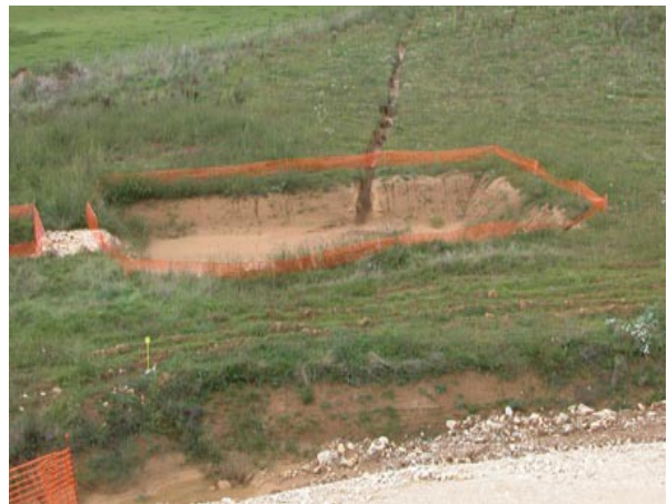
Illustration 9 - Fossés de collecte des eaux de chantier à faible pente
