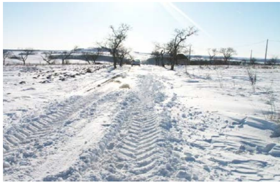
Figure 2 : la route blanche, démarche utilisée pour les routes à faible niveau de service (elle n'est pas adaptée pour le réseau routier national) consiste à s'abstenir de tout salage et à privilégier le raclage voire le sablage pour fixer la neige et permettre le passage d'usagers équipés et auparavant sensibilisés (source : CETE NC)
