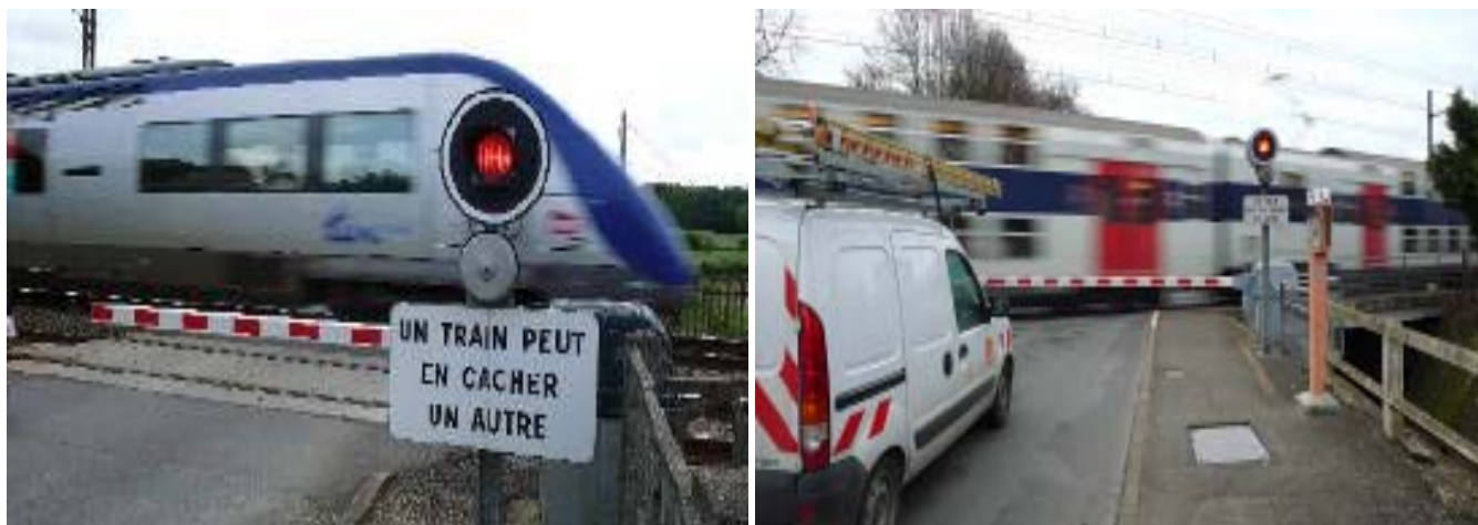
Illustration 1 : signalisation automatique lumineuse et sonore
