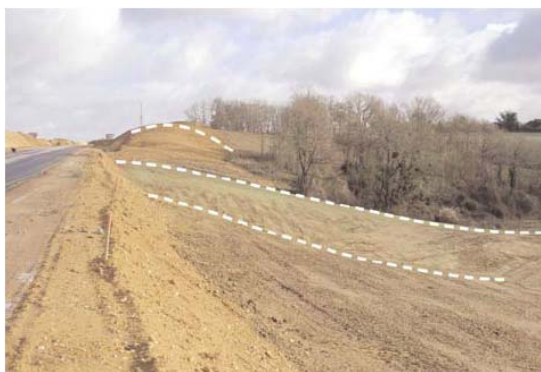
A19 étirement et adoucissement des talus de remblai et de déblai en continuité avec le site
