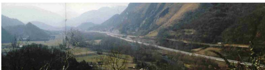
RN 21 au sud de Lourdes, mise à 2*2 voies en chaussées décalées (DDE 65, DGR)
