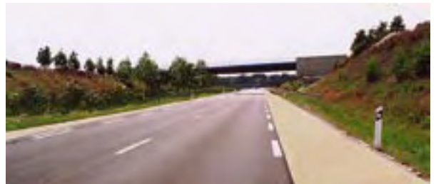
Végétalisation de la chaussée non construite pour réduire le champ de vision – Source : Jean-Louis Chevalier (CETE de l'Ouest)
