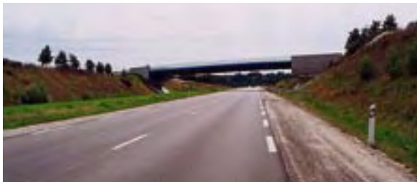
2 x 2 voies réalisées par phasage avec traitement définitif des abords
