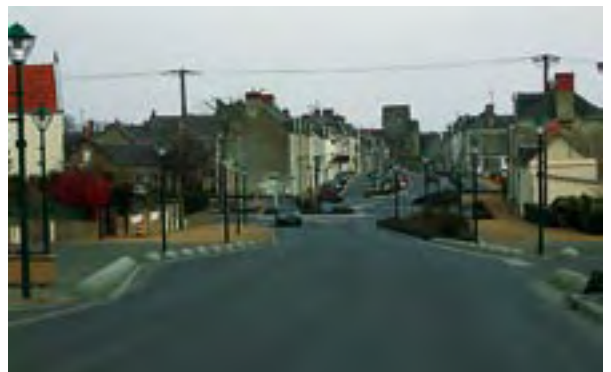
Un travail sur le traitement de la voie et sur le mobilier urbain permet de réaffirmer le caractère urbain de cette traverse d'agglomération Source : Frédéric Gautier et André De Neuville (CETE de l'Ouest)
