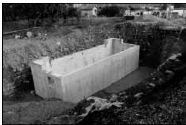
Bassin de stockage
