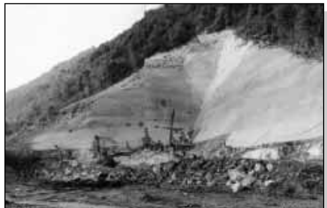
Exemple d'entrée en tunnel (tunnel de Foix)
