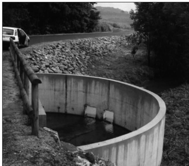
Les débits sont réduits à 0,5 m<sup>3</sup>/s (par deux orifices de 0,4 x 0,6 m). Le déversoir (L = 13,5 m) permet d'évacuer la totalité du débit de pointe sous une lame d'eau de 0,5 m, soit une sécurité de 0,25 m par rapport au niveau fini de la chaussée.
