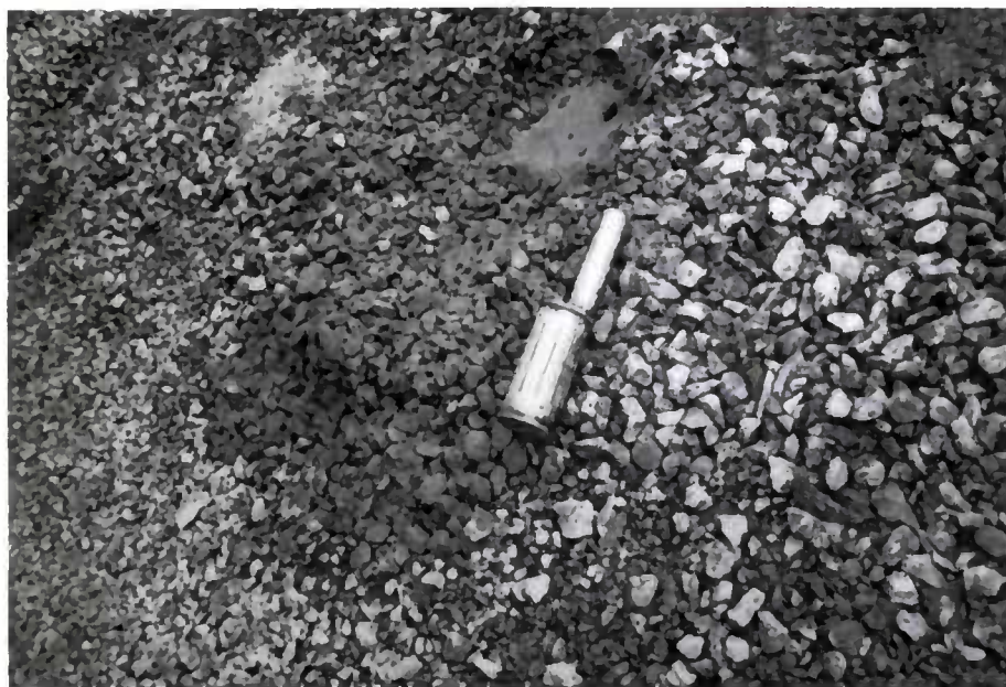
Figure 35 Modèle de crépine pour drainer le remplissage.
