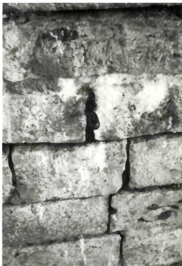
Figure 2 Dissolution des joints entre les pierres.
