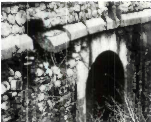
Figure 3 Défauts d'évacuation d'un avaloir provoquant un ruissellement sur les tympans avec, comme conséquence, une altération des joints situés dans la partie touchée.
