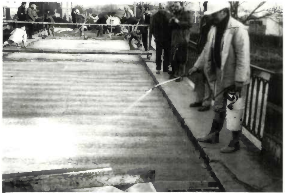
Figure 33 e) L'aspect fini. Noter le profil en long en toit prononcé qui favorise l'écoulement de l'eau.
