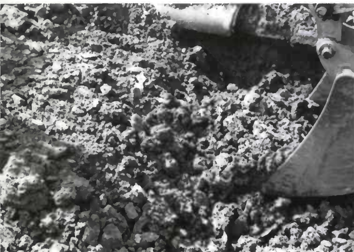
Figure 12 Exemple d'un remplissage en grave très argileuse sur un petit ouvrage.
