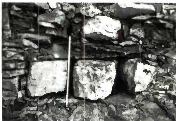
Figure 17 - Quelques aspects de l'état d'une maçonnerie après décaissement complet.
