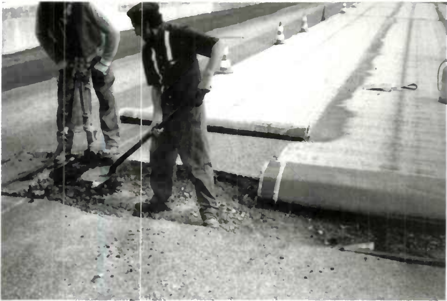
Figure 27 c) Après exécution de la forme en béton armé et de la chape, avant reconstruction de la chaussée.
