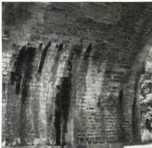
Figure 7 L'humidité entretient une végétation nuisible à la pérennité de l'ouvrage.
