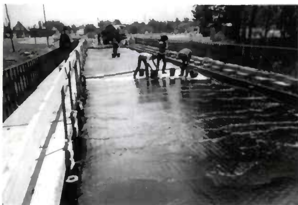
Figure 18 - Etanchéité avec un bicouche asphalt sur papier kraft à trous. Noter l'exécution de pentes vers les avaloirs.
