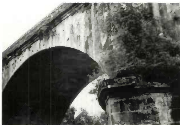
Figure 7 L'humidité entretient une végétation nuisible à la pérennité de l'ouvrage.
