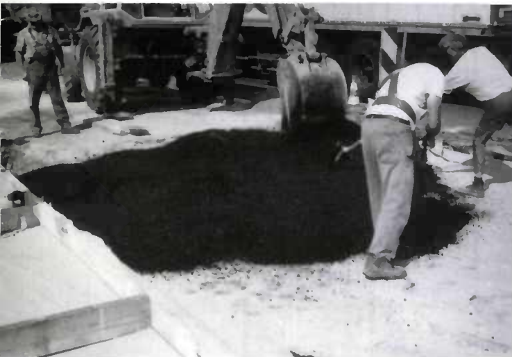
Figure 25 Mise en œuvre manuelle d'une grave bitume sur une géo-membrane protégée par un géotextile non-tissé.
