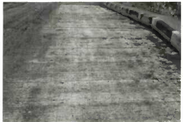
Figure 33 e) L'aspect fini. Noter le profil en long en toit prononcé qui favorise l'écoulement de l'eau.
