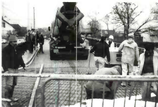
Figure 33 Mise en œuvre d'une dalle en béton armé comportant une étanchéité intégrée. a) Après mise en œuvre d'un béton de propreté, ferrailage de la dalle.
