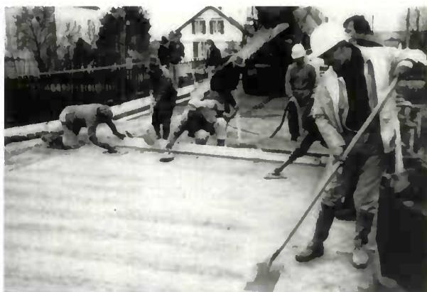
Figure 33 b) Bétonnage et surfacage. Noter, au premier plan, le striage transversal de la surface.
