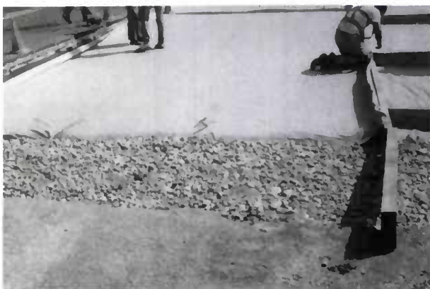
Figure 29 - Fossé drainant d'extrémité b) Le fossé est rempli de son matériau drainant.
