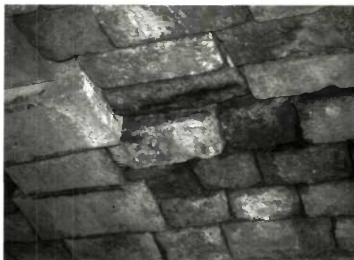
Figure 3 Défauts d'évacuation d'un avaloir provoquant un ruissellement sur les tympans avec, comme conséquence, une altération des joints situés dans la partie touchée.
