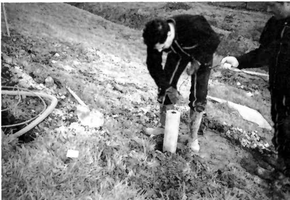
Figure 3.4. : Mise en place d'une anode
