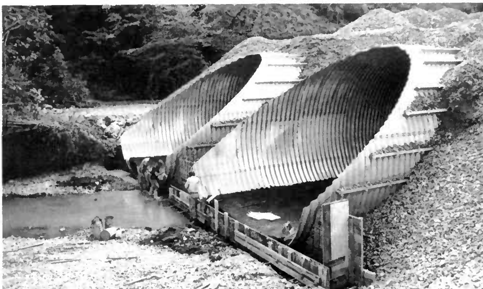
Figure 3.2. : Mise en place d'un radier en béton bitumineux
