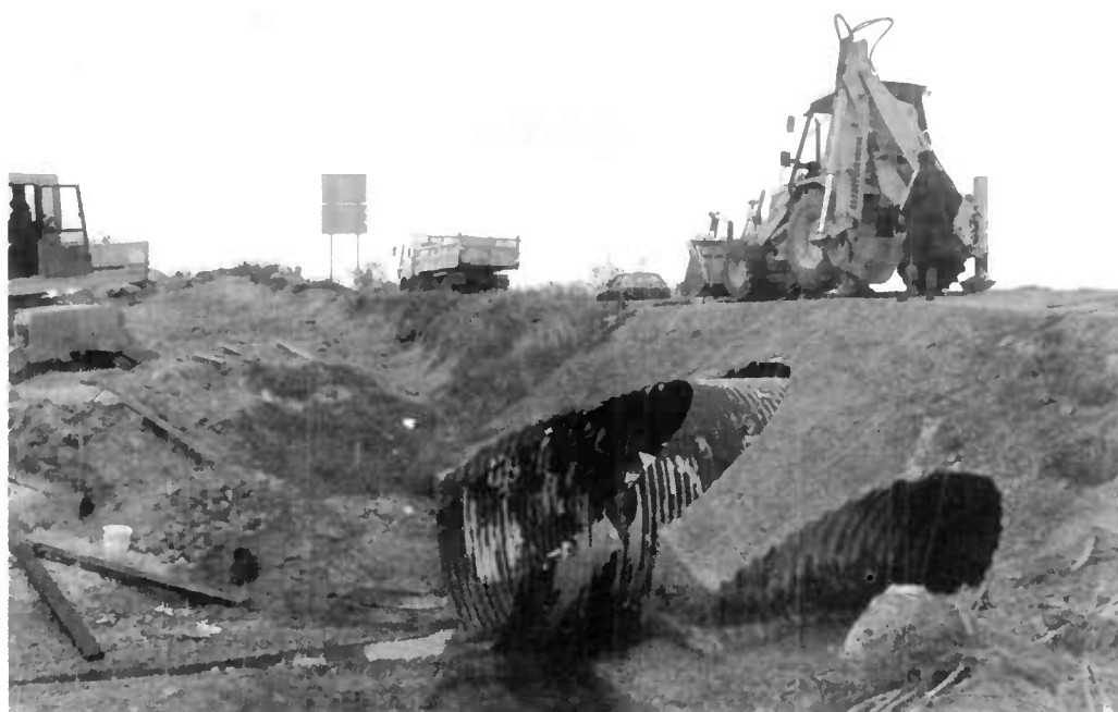
Figure 3.13. : Chemisage par une buse métallique
