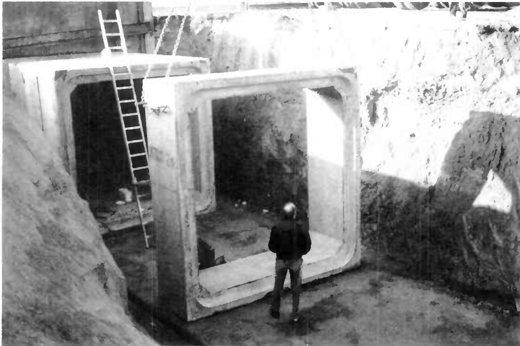
Figure 3.29. : Mise en place d'un élément longitudinal
