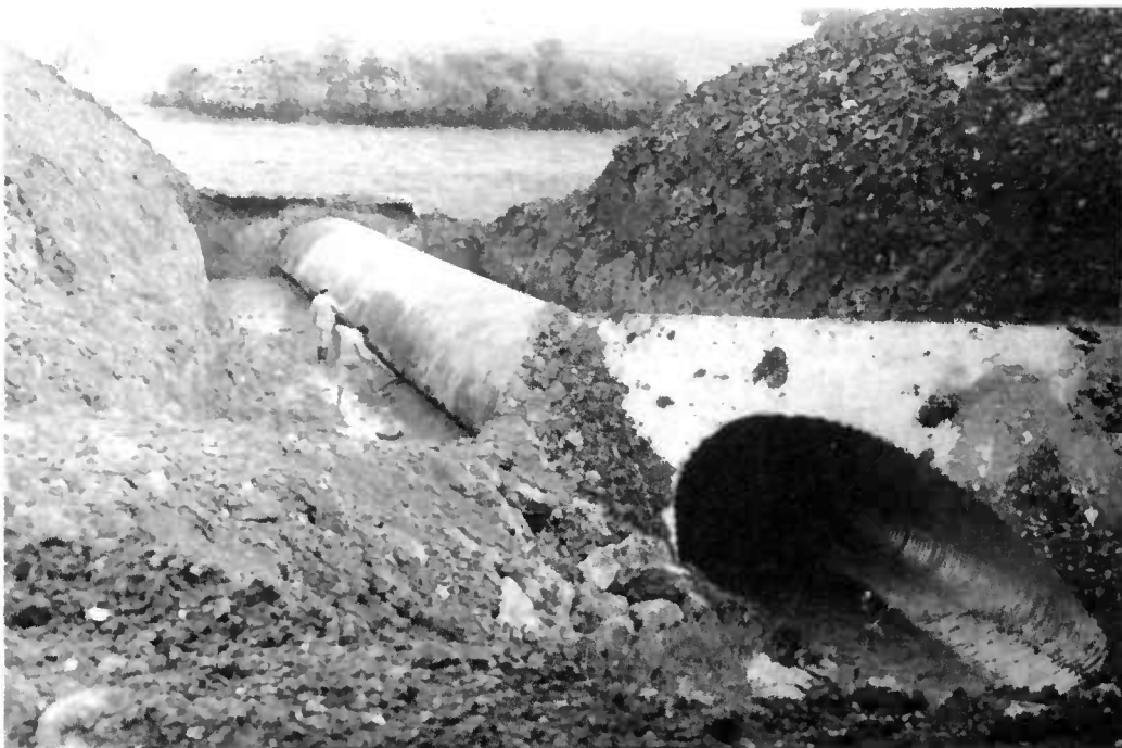
Figure 3.28. : Terrassements pour enlever l'ouvrage existant
