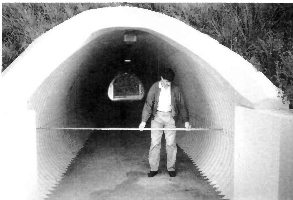
Figure 2.1. : Mesure de la portée à l'aide d'une perche graduée
