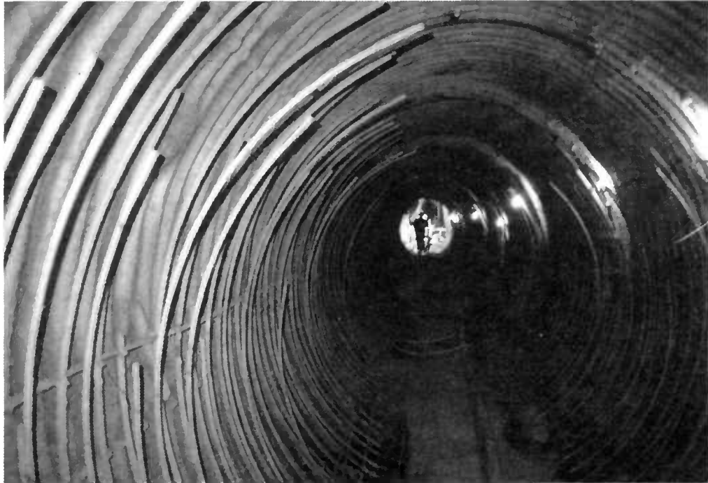
Figure 3.21. : Mise en place de la cage d'armatures
