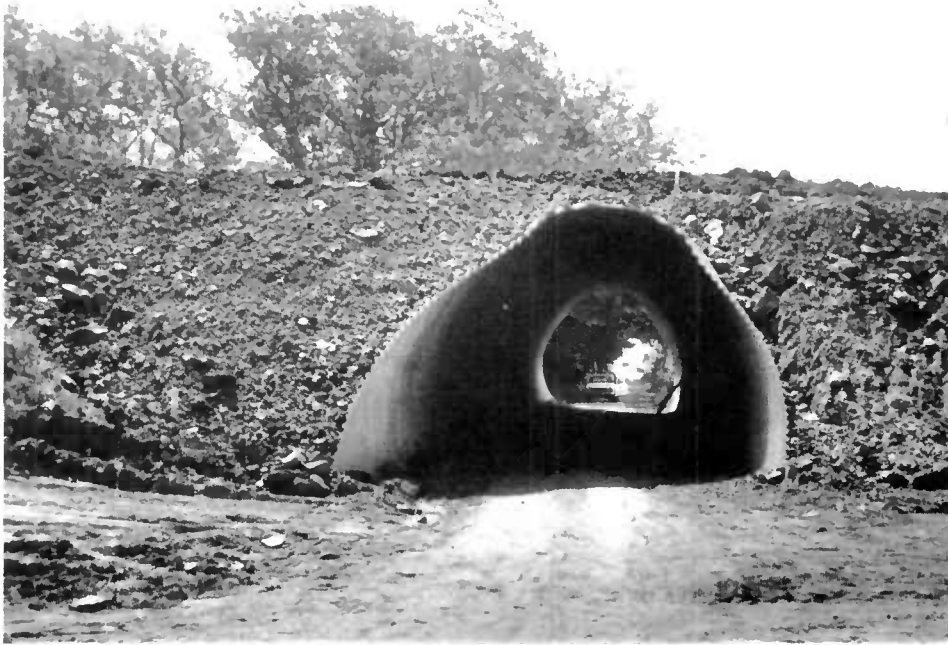
Figure 1.14. : Extrémité déformée en poire
