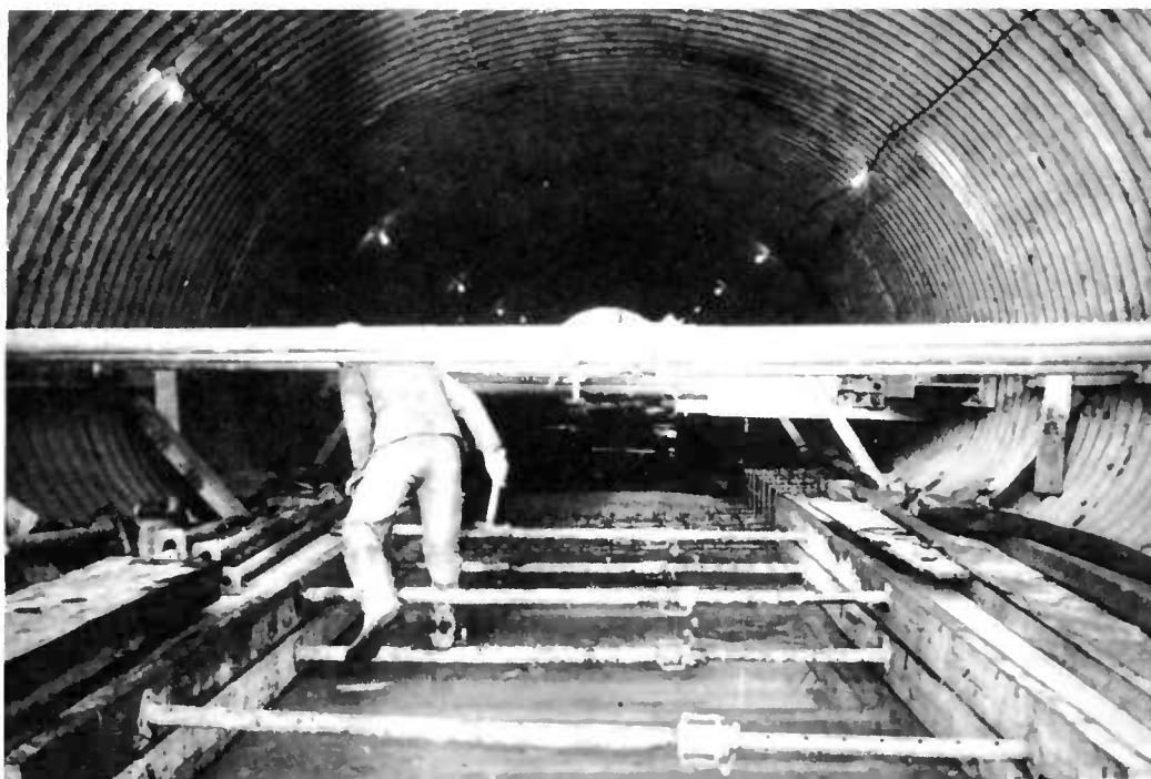
Figure 3.11. : Etaisement en section courante
