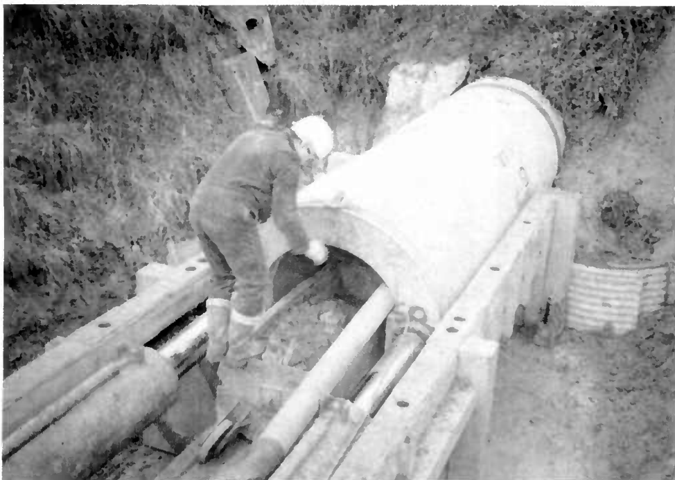
Figure 3.27. : Phase de poussage - Extraction de remblai
