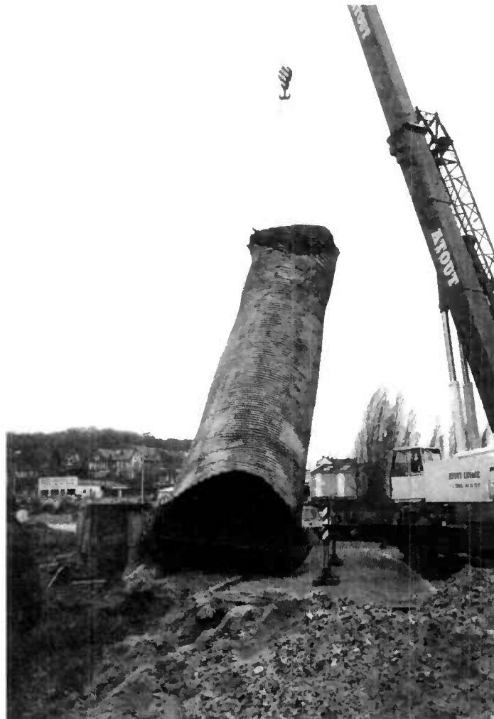
Figure 3.33. : Enlèvement de la buse à la grue
