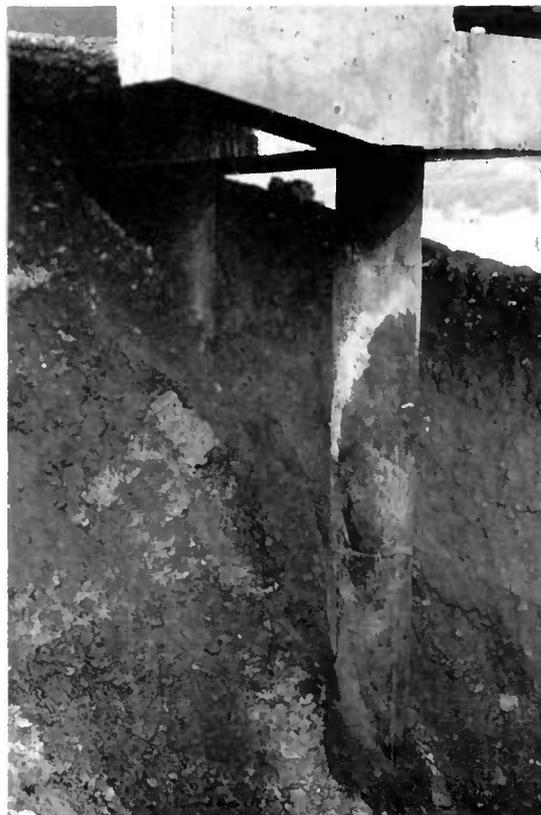
Fig. 5. — Mise à nu de la fondation d'une culée par érosion du remblai.
