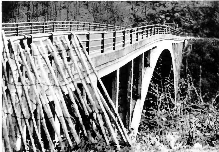
Fig. 4. — Conséquences d'un mouvement de terrain : les culées de l'arc ont été entraînées et se sont rapprochées.
