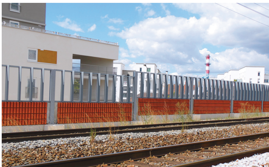
Écran mixte béton de bois / transparent absorbant — Tangentielle Nord — Grand Paris (78, 93, 95)
