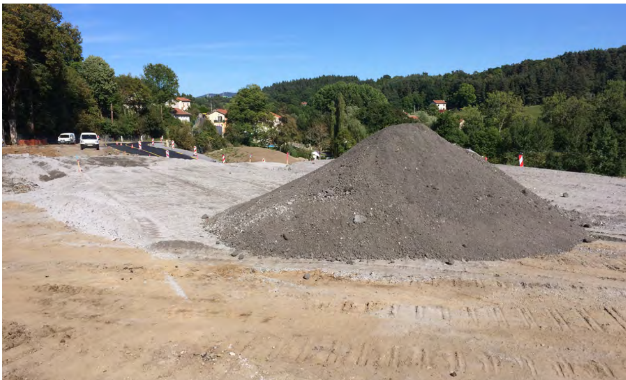
Grave de Mâchefers d'Incineration de Déchets Non Dangereux, juste approvisionnée @Cerema (Sébastien LIANDRAT)
