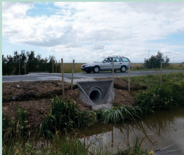
Ouvrage finalisé avec dispositif de grillage pour éviter que les loutres ne remontent sur la chaussée. Source : François Varenne.
