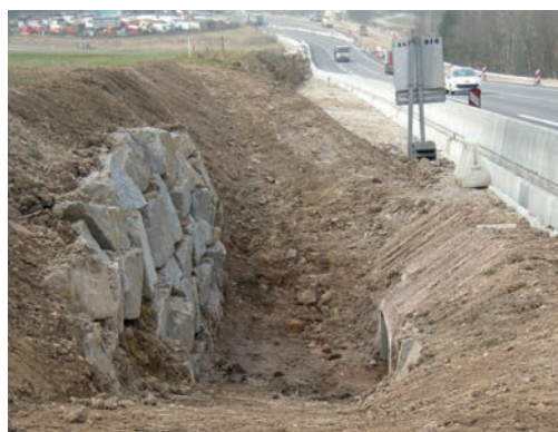
7 Rampe d'accès protégée par un mur maçonné côté dépendances vertes. Source : Cerema.
