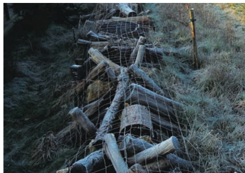
12 Andain grillagé pour éviter le vol et les jets sur l'autoroute. Source : Vinci Autoroutes.
