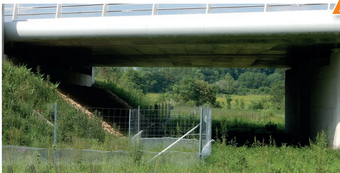
Clôture dont l'implantation fait obstacle au déplacement de la faune. Source : Cerema.
