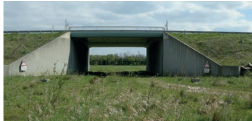
22 Passage inférieur d'une hauteur équivalente au remblai. RN 4 (54). Source : Cerema.
