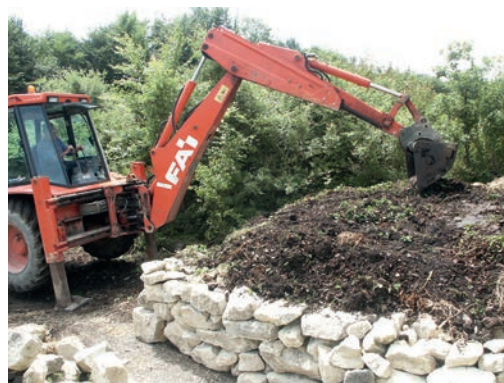
29 Site de ponte / hibernaculum artificiel en cours d'aménagement. Source : X. Bonnet.
