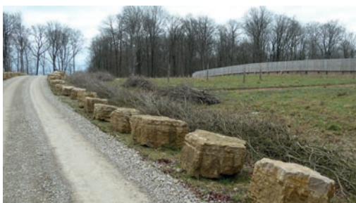
17 Blocs en pierre positionnés le long d'un rétablissement forestier de la LGV Est européenne. Source : Cerema.
