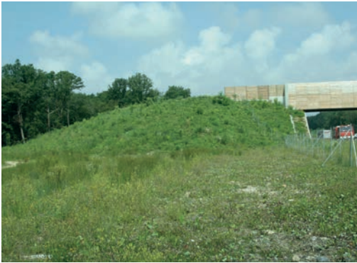
③ Rampe d'accès au passage à faune. RD64 (70). Source : Cerema.
