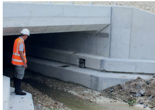
17 Exemple d'abris créés dans la banquette faune d'un ouvrage. Source : Michel Bramard OFB.
