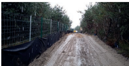
Piste d'accès chantier. Source : ASF/Réseau Vinci Autoroutes.
