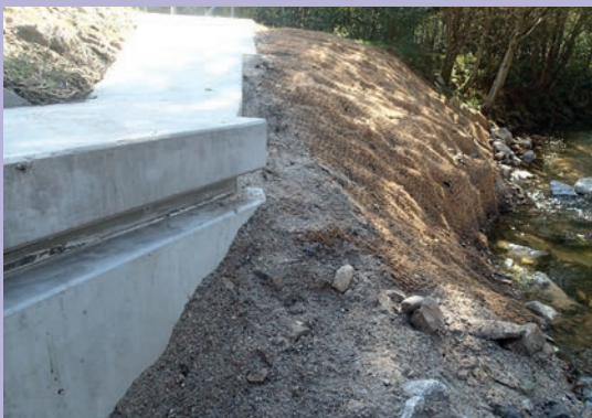
18 Aménagement au sein de la banquette faune d'un cheminement pour les micromammifères*. Source : P. Fournier GREGE.
