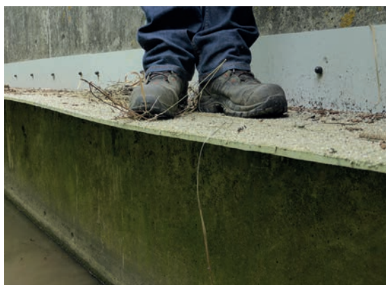
④⑤ Banquette PRV de 50 cm de largeur sur 67 m de long et un tirant d'air de 200 cm. Coût : 35 000 € TTC (2015). Autoroute A83. Source : Cerema.
