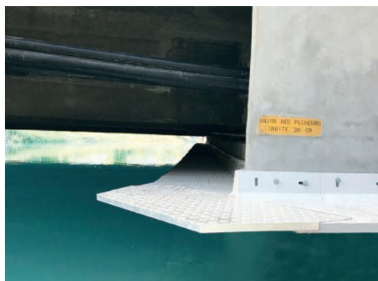
⑦ Banquette en béton polymère avec dispositif antidérapant. Source : ULMA Architectural Solutions.
