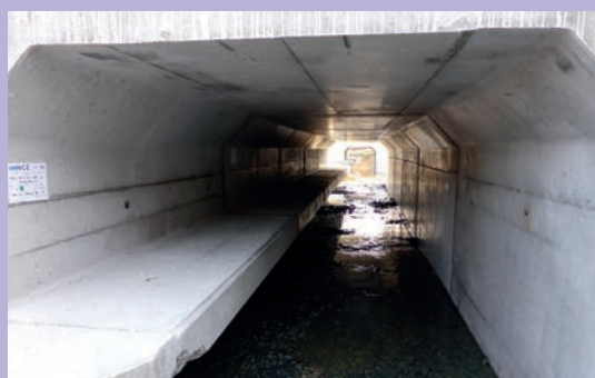
Élément de cadre équipé d'un encorbellement béton préfabriqué. Source : Cerema.
