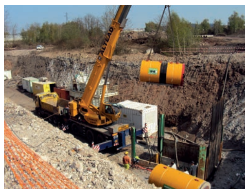
Mise en place d'un microtunnelage sur une voie ferroviaire. Source : Christian Chéreau - SNCF Réseau.
