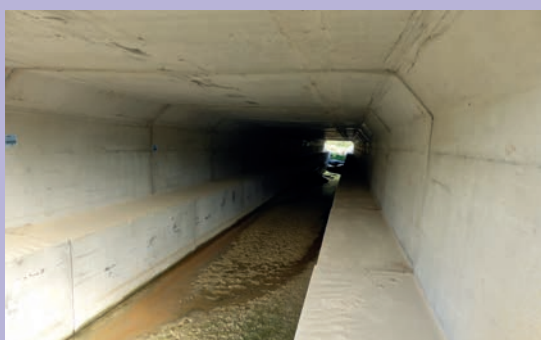
Élément de cadre équipé d'une banquette béton préfabriquée. Source : Cerema.
