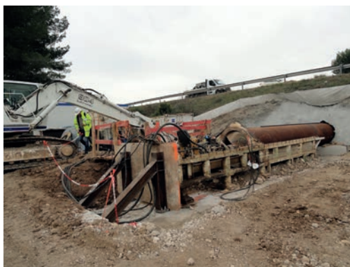
Passage petite faune de Velaux Autoroute A7 : vue sur le dispositif de fonçage. Source : Vinci Autoroutes/Réseau ASF.
