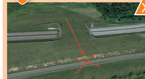
10 Passage à faune débouchant sur une infrastructure. Source : Google Earth.
