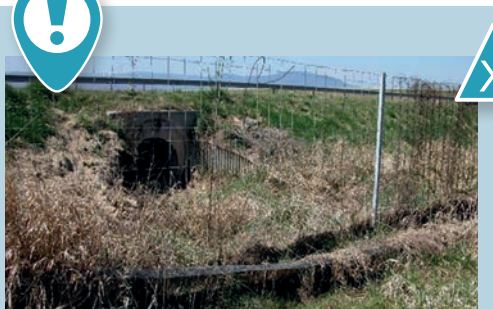
Clôture empêchant la faune d'accéder à l'ouvrage. Source : Cerema.
