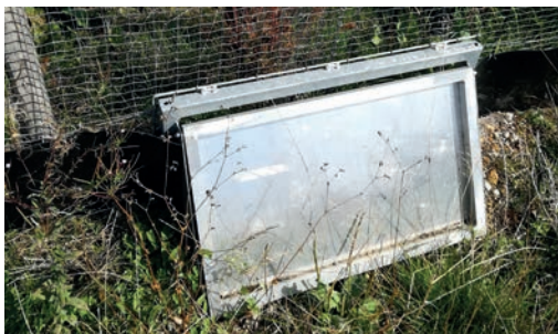
23 Échappatoire petite faune aux Pays-Bas. Source : Cerema.
