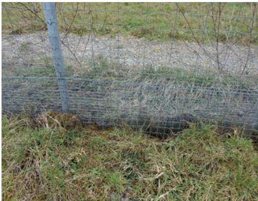
Exemple de clôture à mailles fines adossée à une clôture grande faune à mailles progressives. LGV Est. Source : Cerema.
