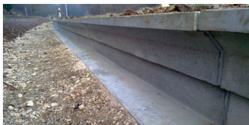
1 Bordure béton. Source : Maibach.
