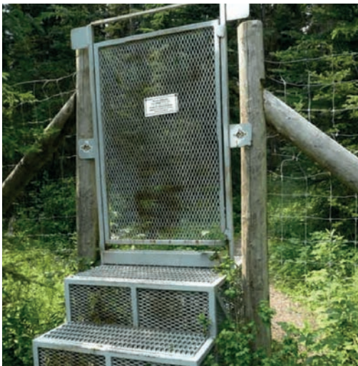
6 Portillon équipé de marches d'accès pour limiter les possibilités d'entrées pour la faune. Source : A. Clevenger.
