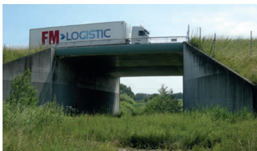
❶ Passage inférieur spécifique ordinaire toute faune. RN 4 (54). Source : Cerema.
