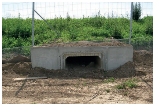
15 Tête d'ouvrage en béton coffré. Source : Cerema.
