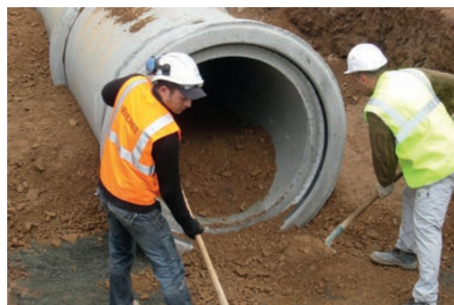
Mise en œuvre manuelle d'une couche de terre à l'intérieur d'une buse. Source : Vinci Autoroutes/Réseau ASF.
