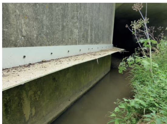
④⑤ Banquette PRV de 50 cm de largeur sur 67 m de long et un tirant d'air de 200 cm. Coût : 35 000 € TTC (2015). Autoroute A83. Source : Cerema.
