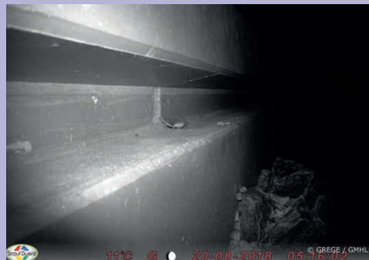
18 Aménagement au sein de la banquette faune d'un cheminement pour les micromammifères*. Source : P. Fournier GREGE.
