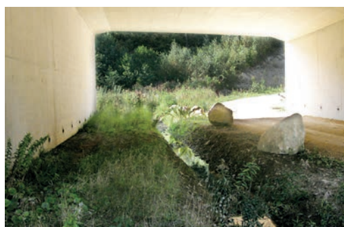
Passage inférieur dont les usages sont séparés par des blocs et le passage d'un cours d'eau (Autoroute A34). Source : Cerema.
