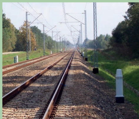
② Poteau UOZ-1 installé le long d'une voie ferrée. Source : www.neel.com.pl
