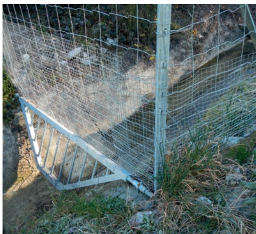
12 Exemple de dispositifs mis en place pour assurer la continuité des clôtures : grille amovible sur fossé. Source : Cerema.
