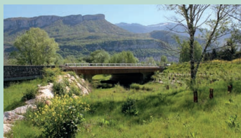
Passage inférieur de la RD121a. Source : Conseil départemental de l'Isère.
