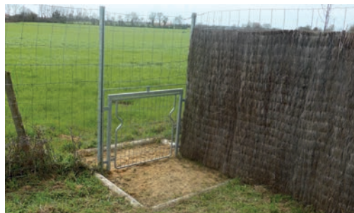
22 Échappatoire, réseau Vinci Autoroutes. Source : Cerema.
