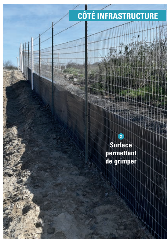
Barrière en polyéthylène haute densité accolée à une clôture. Source : Animex Fencing.
