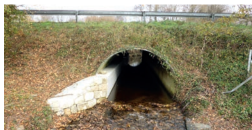
Banquette béton. RN 165 (DIRO). Buse métallique. Source : Cerema.
