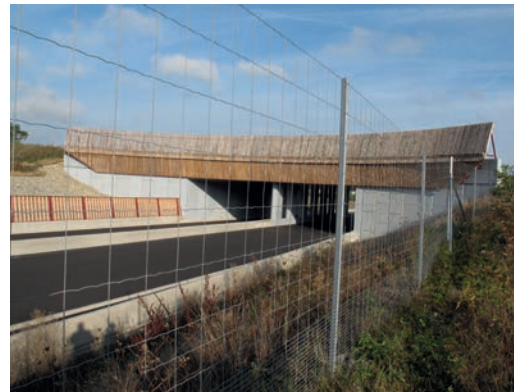
Exemple de clôture grande faune à mailles progressives. RD 16 (CD57). Source : Cerema.
