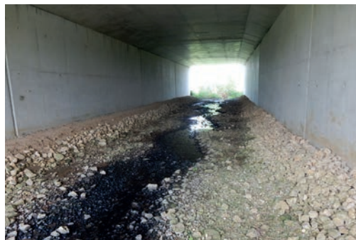
Exemple d'un ouvrage dans lequel quelques sinuosités ont été réalisées dans le lit mineur. Source : Cerema.
