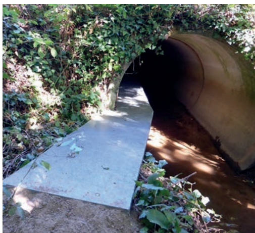
12 Exemple de raccordement à la berge. Source : Cerema.
