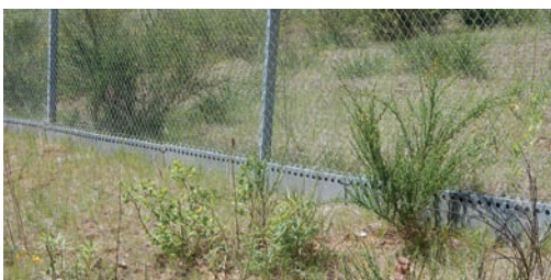
Bordure en plastique recyclé. Autoroute B10, Allemagne. Source : Cerema.
