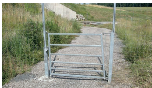
16 Portail piéton dont les gonds sont décalés (plus proche du poteau en bas qu'en haut) pour qu'il se referme automatiquement sans intervention. Source : Cerema.
