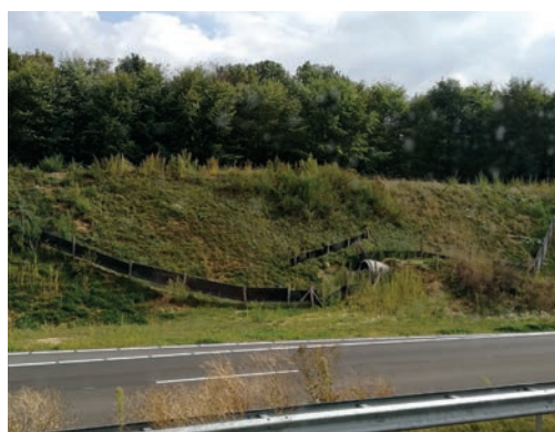
8 Exemple d'un passage petite faune dont la tête d'ouvrage est en pente et parallèle à l'infrastructure. Source : Cerema.
