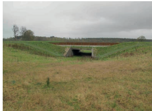
8 Passage inférieur avec fosse d'entonnement. Autoroute A88 (Orne). Source : Cerema.
