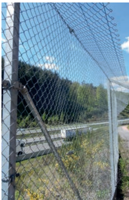
Exemple de clôture avec bavolet pour le lynx. Autoroute B10, Allemagne. Source : Cerema.
