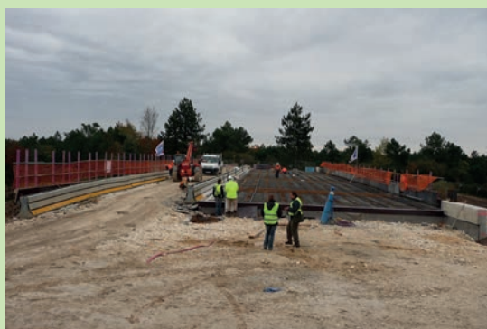
④ Ouvrage en cours de construction. Source : ASF/Vinci Autoroutes.
