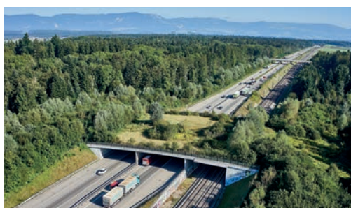
5 Exemple de passage exceptionnel entre Berne et Soleure en Suisse. Source : AURA/Emanuel Ammon.
