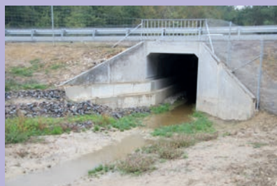
Banquette en gradins (béton). Source : P. Fournier GREGE.
