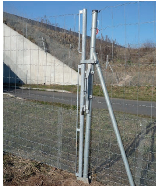
10 Passe américaine correctement clôturée mais ne présentant toutefois pas de seuil béton ni de barre ou câble de tension. Source : JBS Métallerie.
