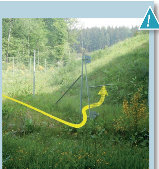
Ouverture dans la clôture laissant l'accès aux emprises. Source : Cerema.
