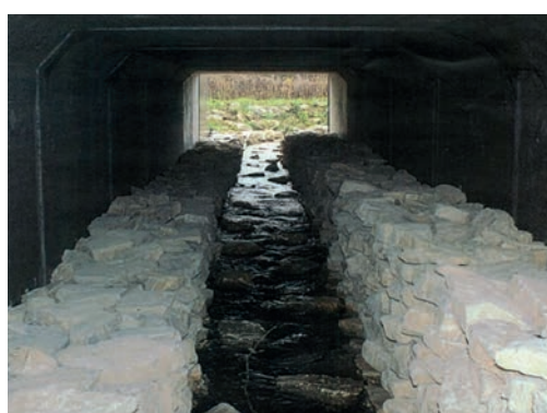
9 Aménagement d'une banquette en matériaux naturels (scellés à l'intérieur) dans l'ouvrage de franchissement du ruisseau des martes sur la RD12.
