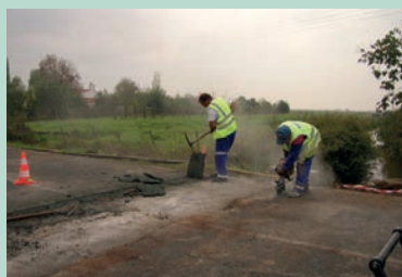
Ouverture de la chaussée pour la pose des éléments de l'ouvrage. Source : François Varenne.
