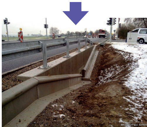
Ouvrage équipé d'une rampe d'accès. Source : Maibach.
