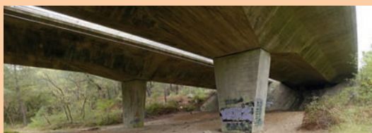
Viaduc de la Vallée chaude. Source : Vincent Vignon/OGE.
