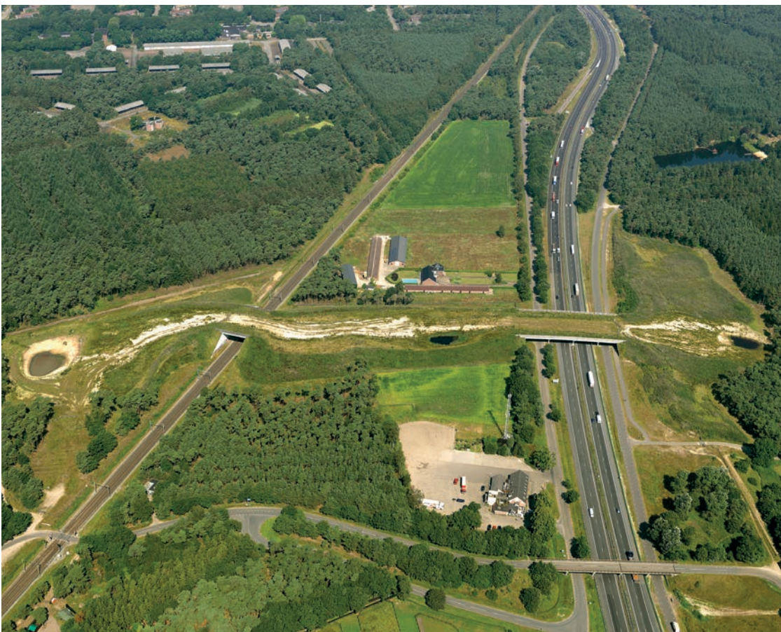
📍 Passage toute faune équipé d'une mare à chaque entrée du passage. Autoroute A2 au nord d'Eindhoven. Source : Luchtfoto Irvin Van Hemert – Pays-Bas.
