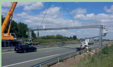
Installation du portique. Source : Vinci Autoroutes/Réseau ASF.
