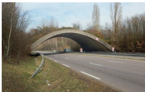
5 Pont en Arc. RD 31, Moselle. Source : Cerema.
