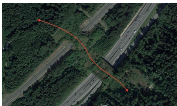
15 Infrastructures jumelées sur chacune desquelles un ouvrage de taille équivalente a été construit. Source : Google Earth.
