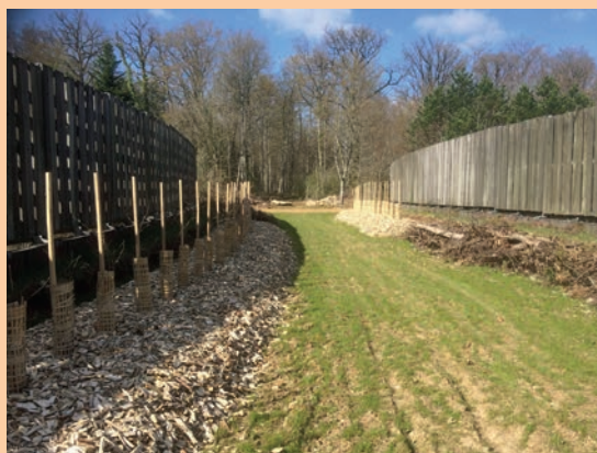
Exemple du passage à faune de Ville-sous-la-Ferté (A5). Source : Cerema.
