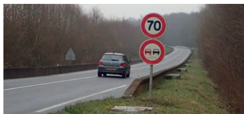
15 Muret en béton assurant le guidage des amphibiens et la sécurité des usagers. Source : Cerema.
