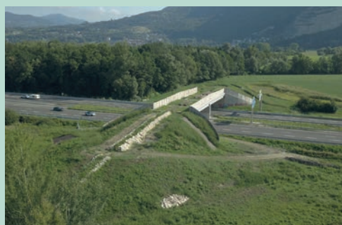
Passage de la Buisse sur l'autoroute A48. Source : R. Courtaud - AREA.
