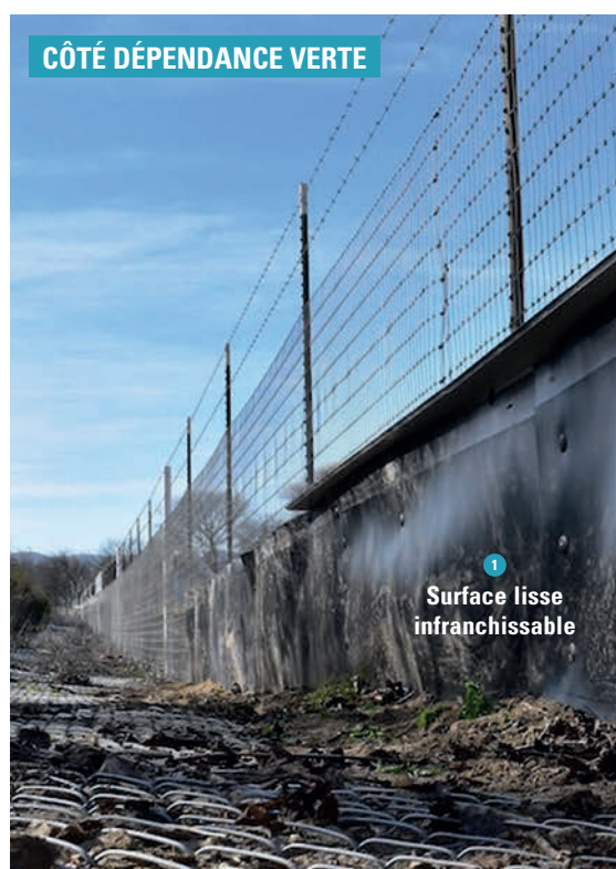
Barrière en polyéthylène haute densité accolée à une clôture. Source : Animex Fencing.
