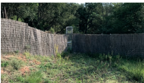
27 Système « Sangli-pass » installé dans un coin de la clôture. Source : Cabinet X-Aequo.
