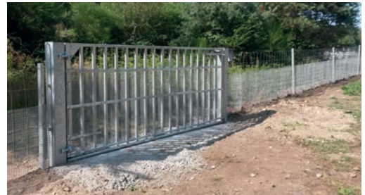
5 Portail équipé d'un seuil béton. Source : Vinci Autoroutes/Réseau ASF.
