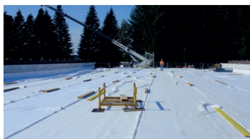
Phase d'étanchéité et de drainage du tablier. Source : Vinci Autoroutes/Réseau ASF.
