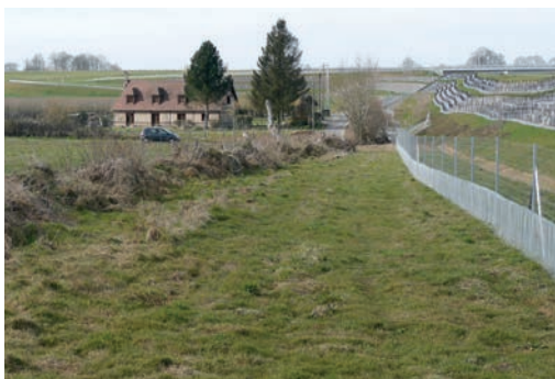
④ Réalisation d'un andain en bordure d'emprise de l'autoroute A150.
