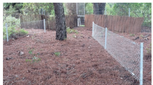
28 Installation de 2 clôtures guides vers le dispositif. Source : IMPCF.
