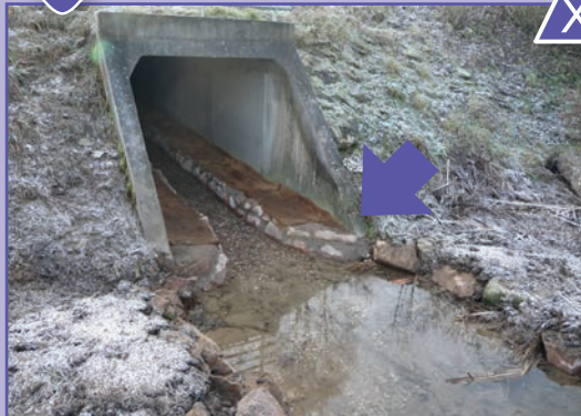
13 Banquette en matériaux naturels non raccordée à la berge. Ouvrage de Verdenal (54). RN4 Strasbourg-Nancy. Source : DIR Est.
