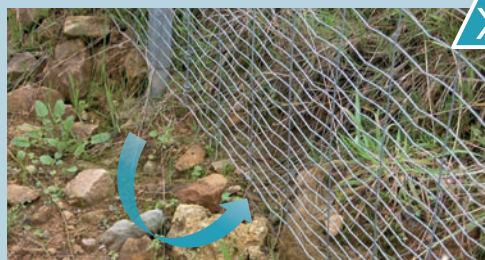
Grillage à mailles progressives non enterré, non broché et laissant libre accès aux emprises pour la petite faune. Source : Cerema.
