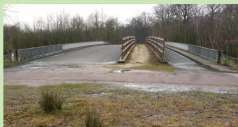
Vue de l'ouvrage avant travaux. Source : Vincent Vignon, OGE.
