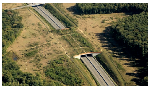
6 Tranchée couverte de l'autoroute A19 dans la traversée de la forêt de Montargis. Source : Arcour.
