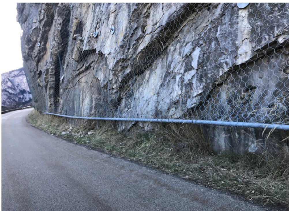
Figure 16 : Ligne de rive inférieure lestée (Source : NGE)
