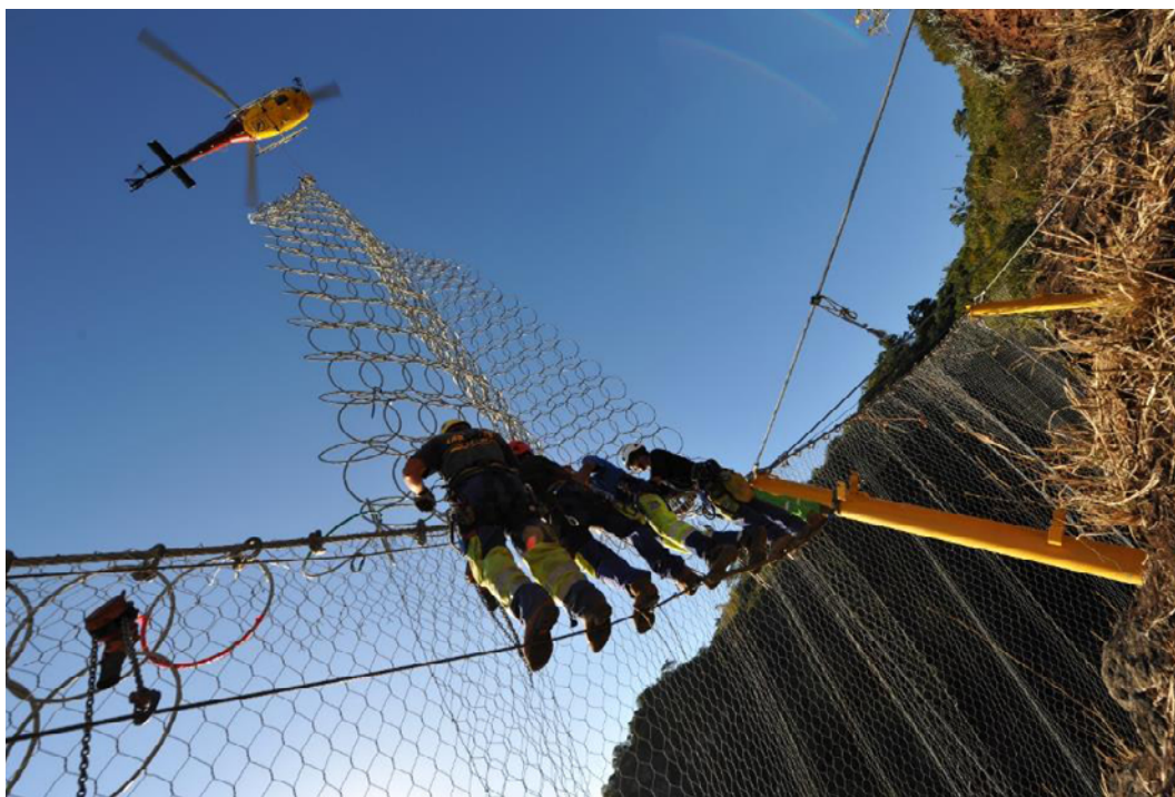
Figure 23 : Hélicoptage d'un filet d'avaloir (Source : NGE)
