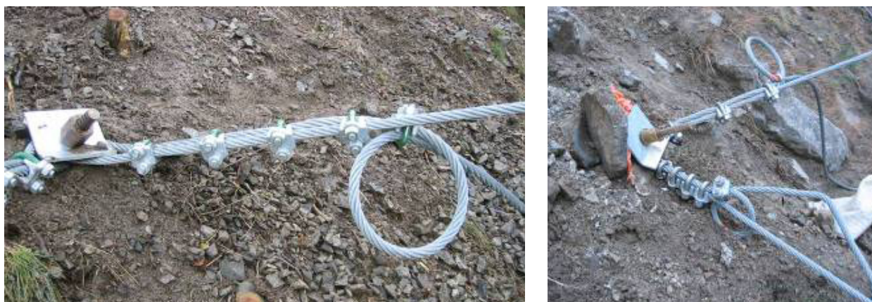
Figure 26 : Boucle anti-échappement, avant (à gauche) et après sollicitation (à droite) - (Source : NGE)
