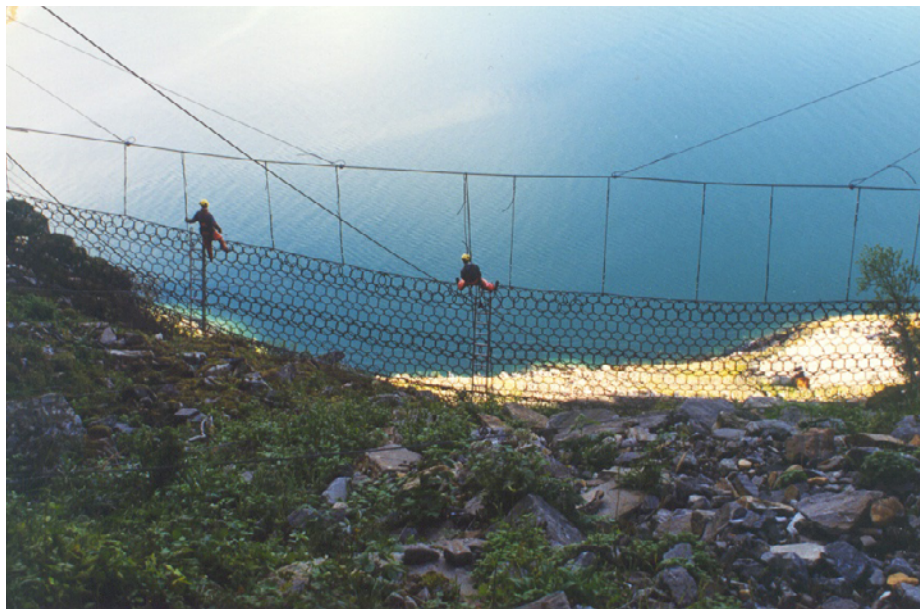
Figure 12 : Exemple de système de suspension (Source : AVAROC)
