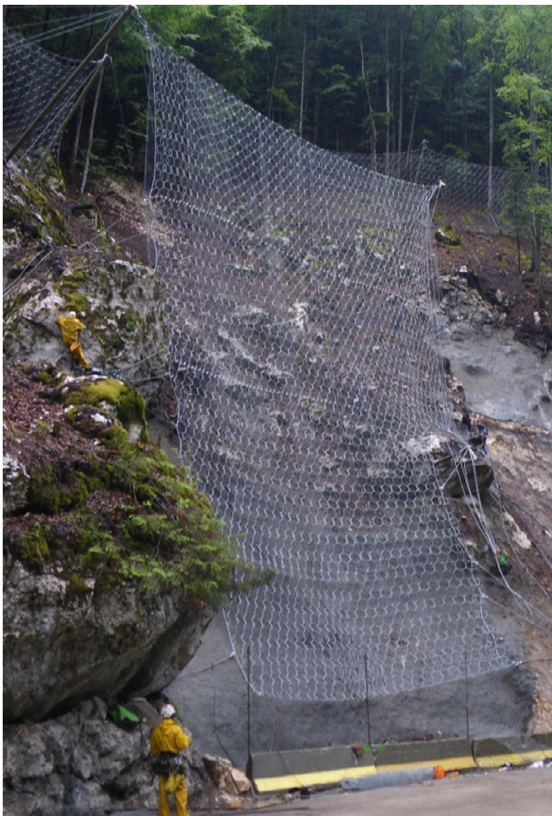
Figure 19 : Structures de liaison latérales - câbles de rive latérale et élingues de déport (Source : CAN)
