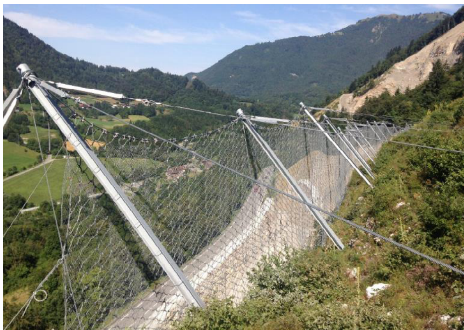
Figure 14 : Avaloir dérivé d'un écran ETAG (Source : NGE)
