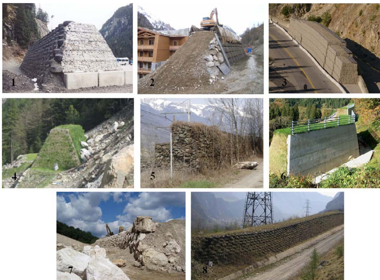
Figure 6 : Illustration de la diversité des dispositifs de protection par merlon (Sources : Lambert et Bourrier, 2013)
