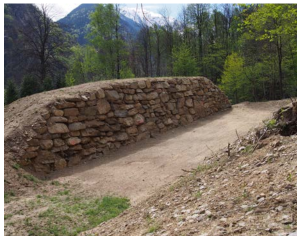
Figure 9 : Merlons avec parement en enrochement. Sur la partie inférieure du talus amont et sur toute la hauteur du talus (Sources : photo de gauche, ONF-RTM - photo de droite, S. Lambert)
