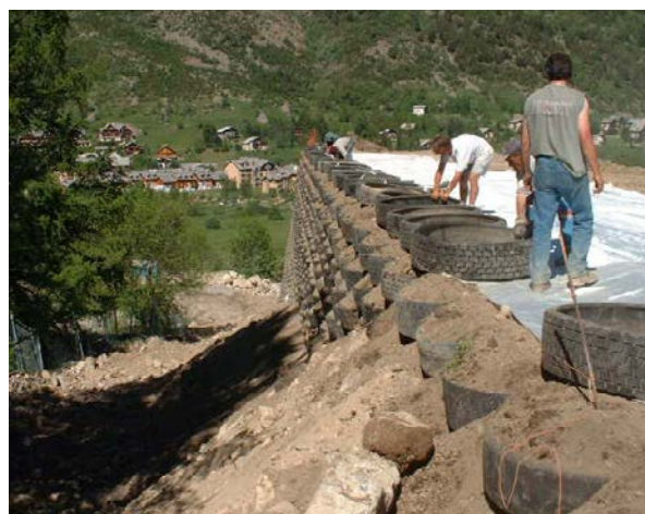
Figure 11 : Merlons constitués de pneus usagés déflanqués. Liaisonnement entre pneus (gauche) et mise en œuvre au parement, combiné avec un remblai renforcé par géotextile (droite) (Sources : photo de gauche, Géolithe - photo de droite, Alpes Ingé)
