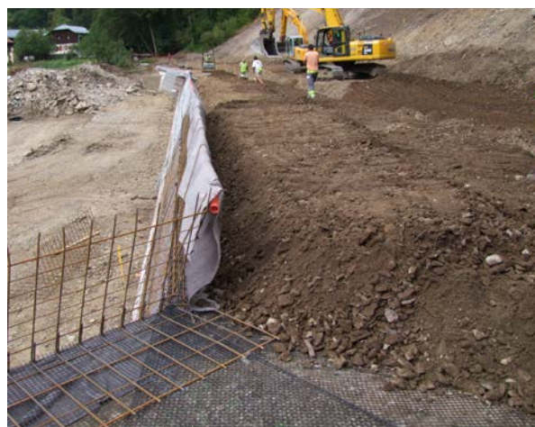
Figure 10 : Merlon à parement raidi renforcé par grillage (gauche) et par géogrille (droite) (Sources : photo de gauche, ONF-RTM - photo de droite, Géolithe)
