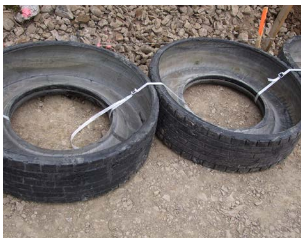
Figure 11 : Merlons constitués de pneus usagés déflanqués. Liaisonnement entre pneus (gauche) et mise en œuvre au parement, combiné avec un remblai renforcé par géotextile (droite) (Sources : photo de gauche, Géolithe - photo de droite, Alpes Ingé)
