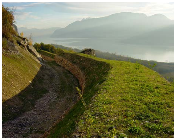
Figure 9 : Merlons avec parement en enrochement. Sur la partie inférieure du talus amont et sur toute la hauteur du talus (Sources : photo de gauche, ONF-RTM - photo de droite, S. Lambert)
