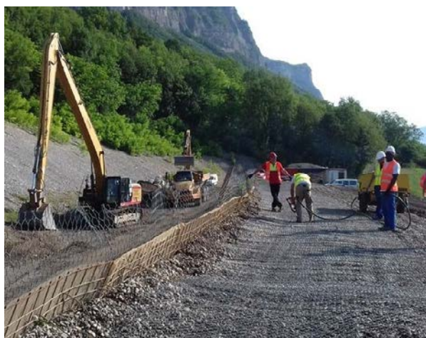
Figure 10 : Merlon à parement raidi renforcé par grillage (gauche) et par géogrille (droite) (Sources : photo de gauche, ONF-RTM - photo de droite, Géolithe)
