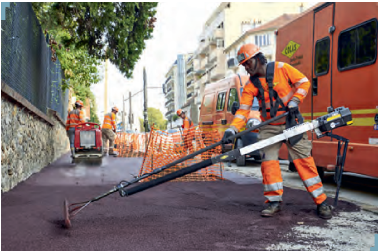
Illustration 15 : ExoPush, exosquelette permettant de mécaniser les opérations de tirage d'enrobé en milieu urbain. (Source : Colas)
