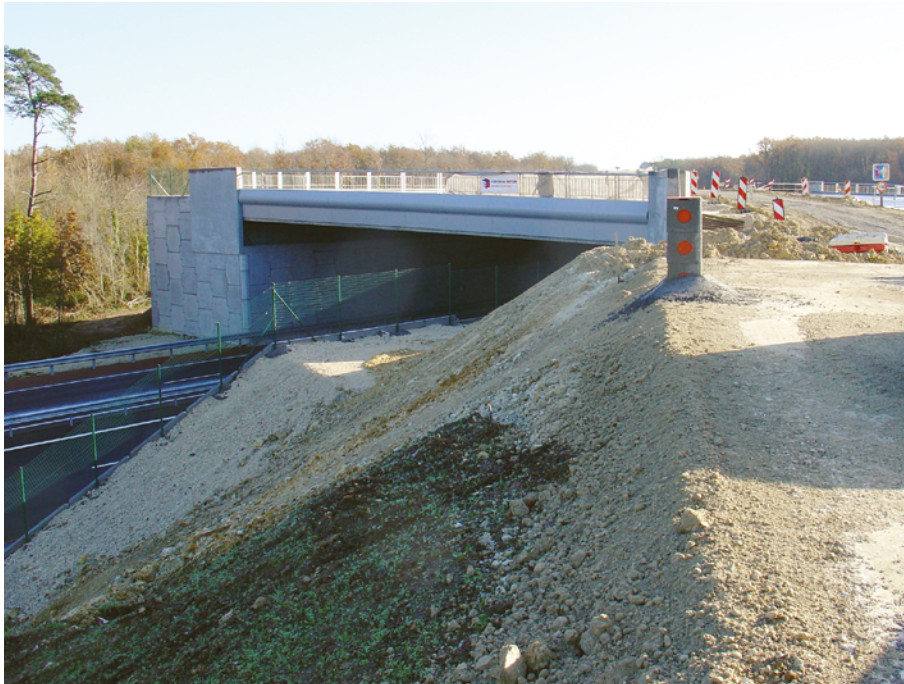
Figure 42 : Grand remblai instrumenté par un inclinomètre (Source : Cerema Normandie-Centre)
