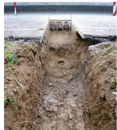
Figure 36 : Tranchée en bande d'arrêt d'urgence (Source : Cerema Sud-Ouest). La fissure coïncide avec la transition entre la structure traitée et le matériau érodé
