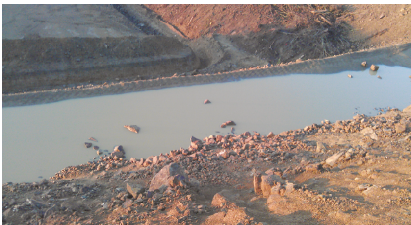
Figure 30 : Stagnation d'eau en risberge intermédiaire (remblai en cours de construction) (Source : Cerema Ouest)
