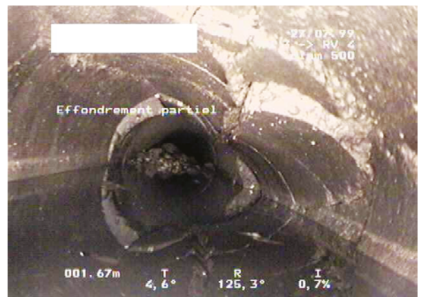
Figure 16 : Exemple d'auscultation de réseaux d'eau enterrés qui sont autant de point d'infiltration d'eau dans le remblai (à gauche déboîtement de tuyau, à droite, effondrement et obstruction d'un tuyau) (Source : Cerema Est)
