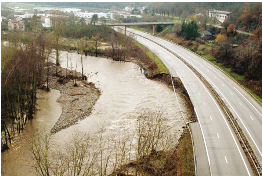
Figure 11 : Érosion d'un talus de remblai consécutive à la crue du Gier (69) (Source : DIR Centre-Est)
