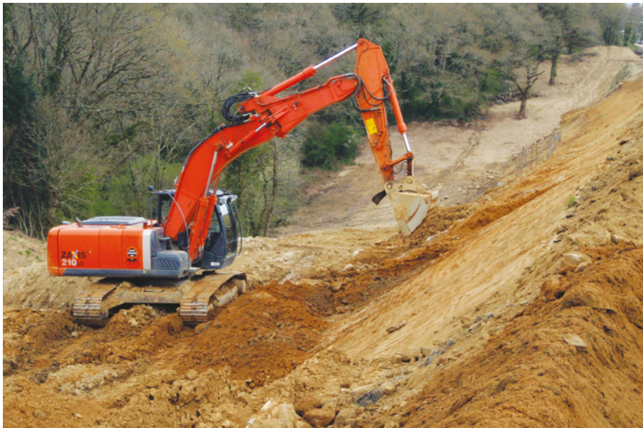
Figure 9 : Élimination du bord de talus excédentaire (Source : Cerema Ouest)
