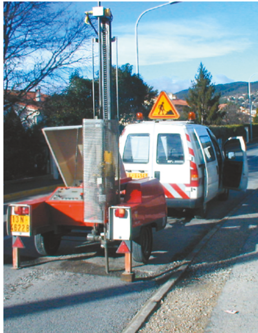
Figure 38 : Reconnaissance au pénétroréactif d'un remblai fissuré en crête - le défaut est lié à un sous-compaction de la zone latérale du remblai qui se manifeste par un tassement différentiel (Source : Cerema Normandie-Centre)
