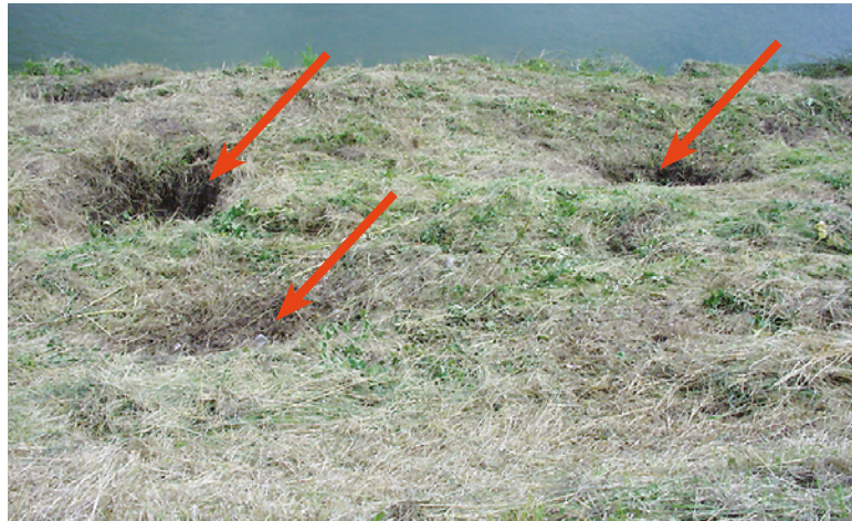
Figure 4 : Zone d'effondrement de la chaussée par suite de remontée d'une cavité karstique dans le remblai (Source : Cerema Normandie-Centre, Jargeau, 2001) - photo prise après rebouchage de la cavité (à gauche) aperçu du phénomène de soutirage par les cavités karstiques, en pied de remblai (à droite)
