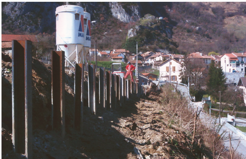
Figure 48 : Chantier de renforcement d'un remblai par paroi berlinoise (source : Cerema Sud-Ouest)
