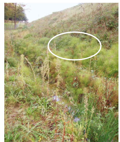
Figure 31 : Végétation typique de zones humides (prêles, rond blanc dans la figure) en pied de remblai (Source : Cerema Sud-Ouest)
