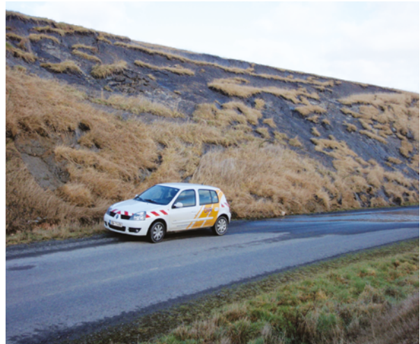
Figure 22 : Glissements superficiels (Source : Cerema Ouest)
