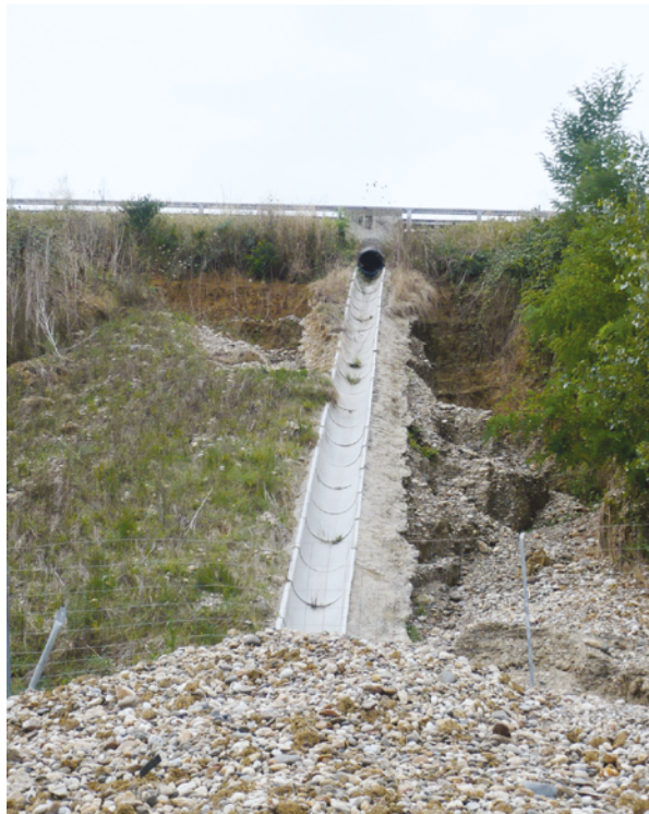
Figure 15 : Ravinements de talus de remblai dus à des débordements de descente d'eau (Source : Cerema Sud-Ouest)
