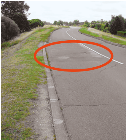
Figure 4 : Zone d'effondrement de la chaussée par suite de remontée d'une cavité karstique dans le remblai (Source : Cerema Normandie-Centre, Jargeau, 2001) - photo prise après rebouchage de la cavité (à gauche) aperçu du phénomène de soutirage par les cavités karstiques, en pied de remblai (à droite)
