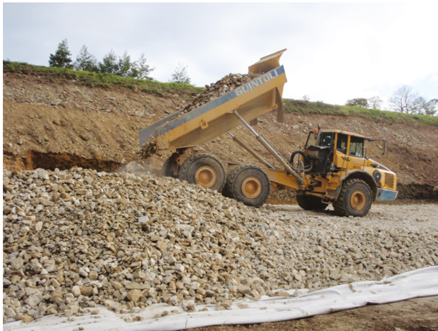
Figure 47 : Mise en œuvre d'une butée en matériau frottant (Source : Cerema Ouest)
