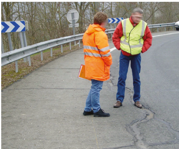
Figure 23 : Fissuration sur chaussée et basculement des panneaux de circulation en accotement provoqués par des phénomènes de reptation de talus (Source : Cerema Sud-Ouest)
