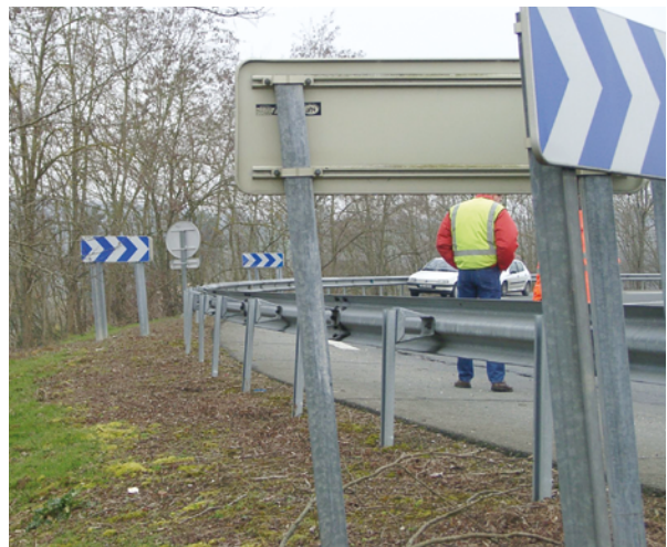
Figure 23 : Fissuration sur chaussée et basculement des panneaux de circulation en accotement provoqués par des phénomènes de reptation de talus (Source : Cerema Sud-Ouest)
