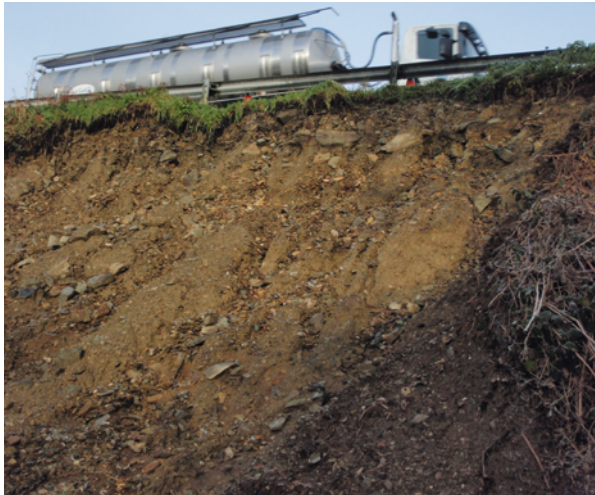
Figure 22 : Glissements superficiels (Source : Cerema Ouest)
