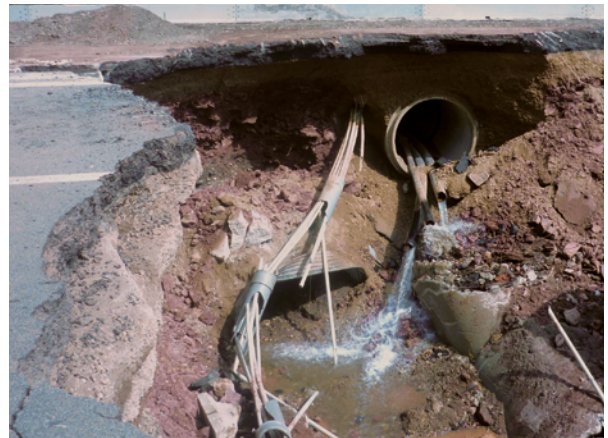
Figure 33 : Effondrement d'un remblai autoroutier sur l'A75 suite à l'érosion des matériaux contigus à un ouvrage hydraulique lors d'un épisode pluvieux particulièrement intense. (Sources : Figure de gauche - Détachement Aérien de Gendarmerie de Montpellier - Figure de droite, DIR MED)
