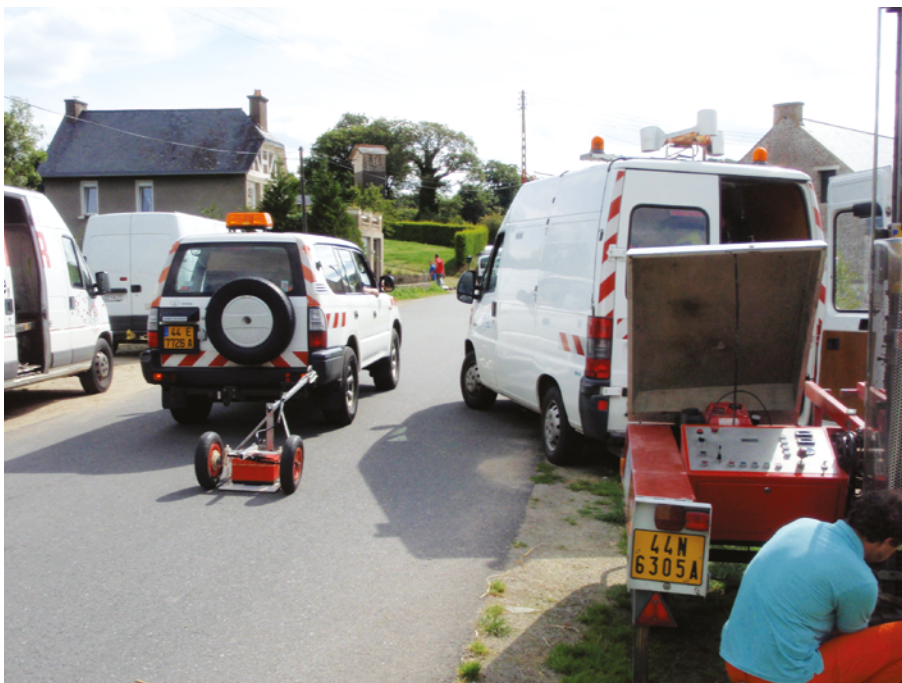
Figure 39 : Passage radar (à gauche) et vérification des anomalies au pénétrodensitographe (à droite) (Source : Cerema Ouest)
