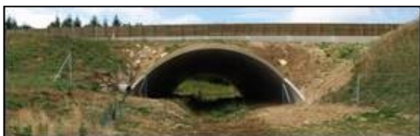
Ouvrage inférieur de l'autoroute A88 équipé d'un écran d'occultation (Source : Groupe mammologique Normand)
