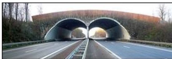
Écran d'occultation sur un ouvrage supérieur de la RN 2 - Forêt de Retz (Source : DIR Nord)
