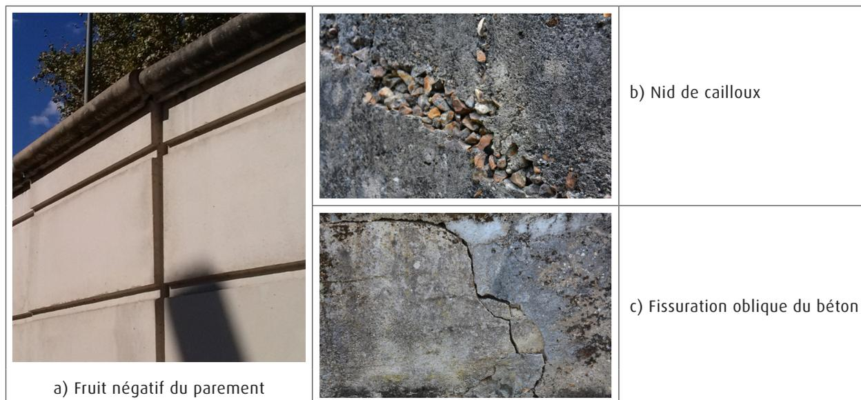
Figure 18 : Exemples de défauts du parement
