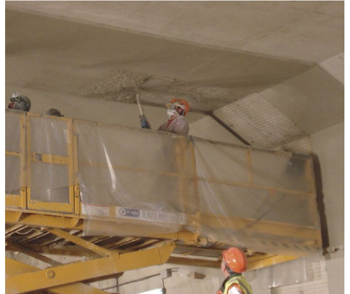
Mise en place de matériau projeté
