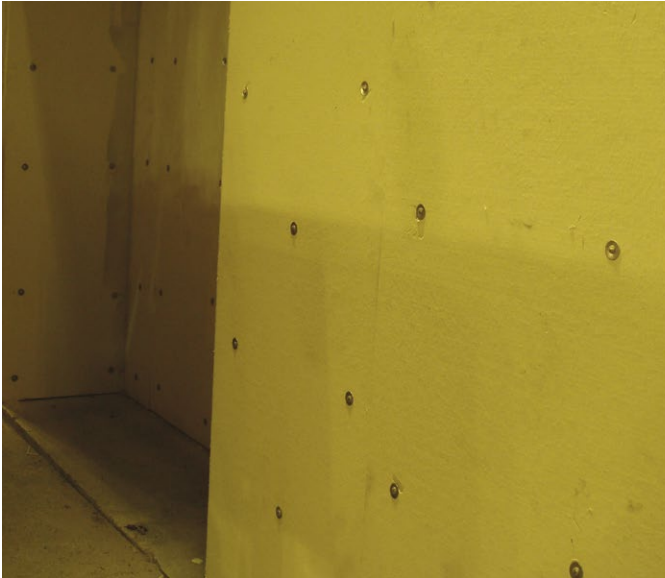
Mise en place de plaques
