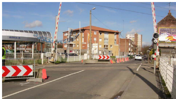
Figure 12: Chantier à proximité d'un PN
