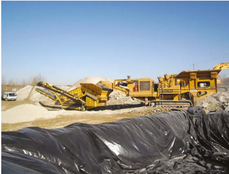
Illustration 1 : Opération de concassage criblage de béton de démolition par une unité mobile (Source : Fédération Nationale des Travaux Publics).
