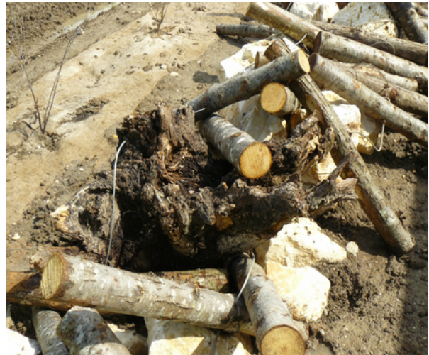
Photographie 3 : Détail de l'andain (pierres, souches et rondins de bois reliés ensemble – A10 DTer SO)
