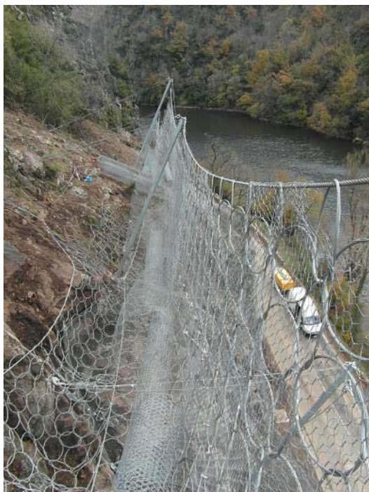
Figure 11. Adaptation de l'ouvrage à de fortes irrégularités topographiques du terrain (RD 920, Aveyron, octobre 2013. Source : CG12).
