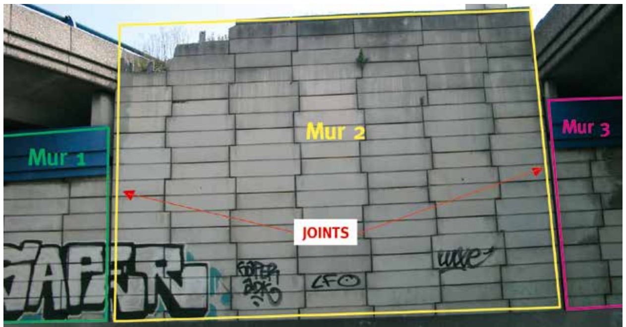
Figure 4 - Murs de fronts séparés par des joints
