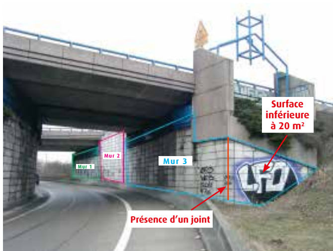
Figure 5 - Mur en aile dans le prolongement d'un mur de front
