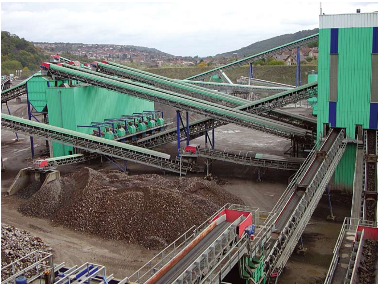
Figure 3 - Installation de concassage - criblage de laitier de haut-fourneau phosphoreux (SLAG)
