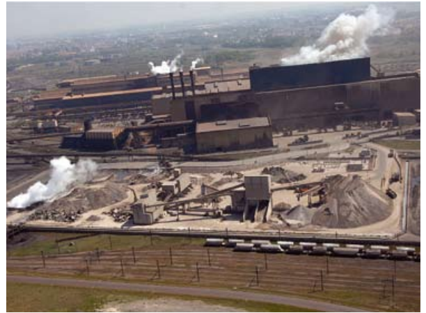
Figure 6 - Installation d'élaboration des granulats de laitiers de convertisseurs (site SGA)
