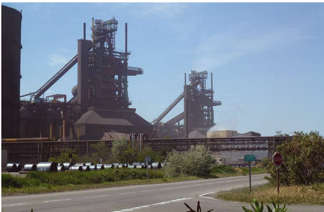
Figure 1 - Vue générale de deux hauts-fourneaux d'une installation sidérurgique (site Arcelormittal de Fos-sur-Mer, 13)
