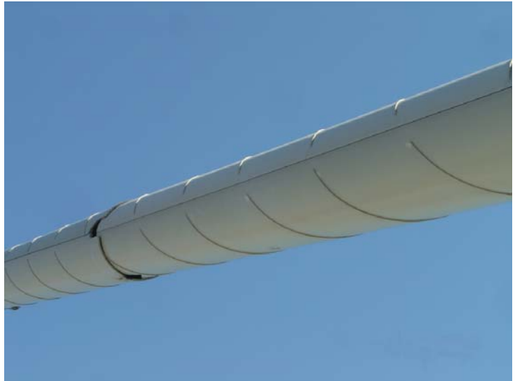
Figure 16 : gaine spiralée du pont de Normandie
