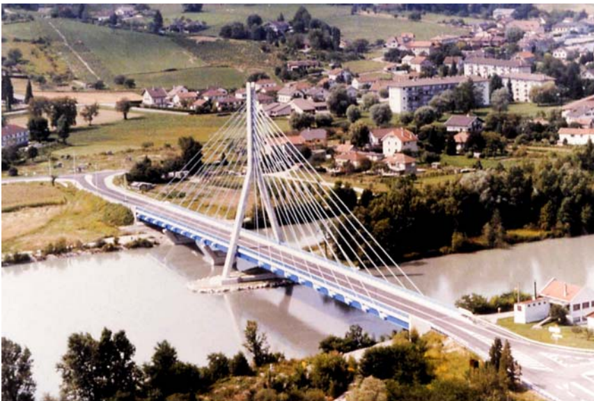
Figure 3 : pont de Seyssel dans l'Ain
