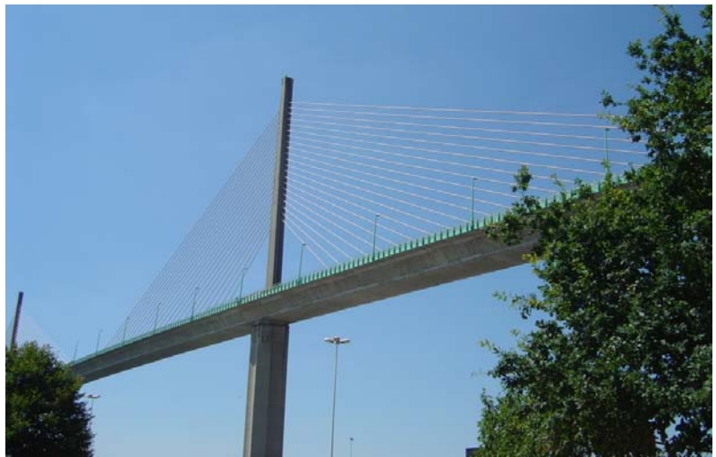
Figure 1 : pont de Brotonne sur la Seine
