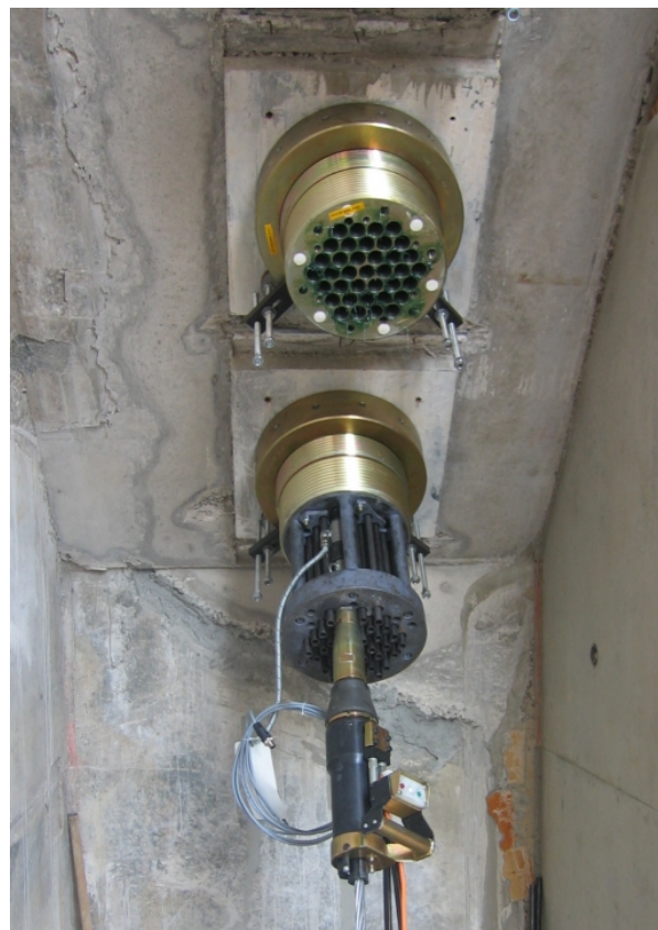
Figure 15 : ancrages des haubans à torons individuels
