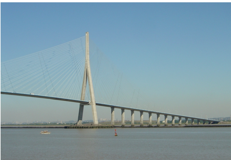
Figure 2 : pont de Normandie
