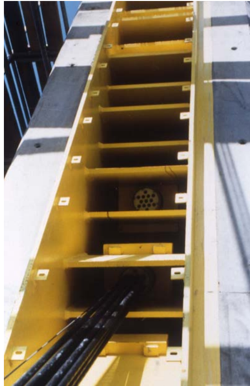
Figure 9 : ancrage des haubans dans une boîte métallique
