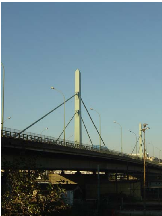
Figure 4 : pont Masséna à Paris
