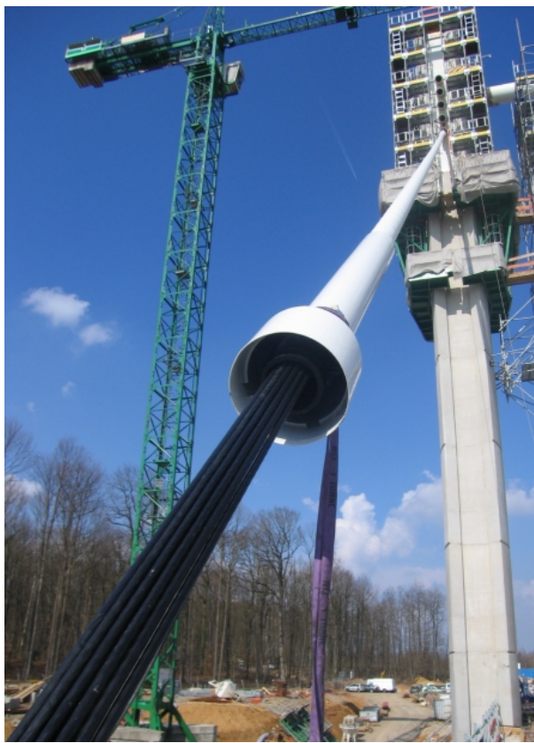
Figure 14 : haubans à torons individuels avec gaine générale
