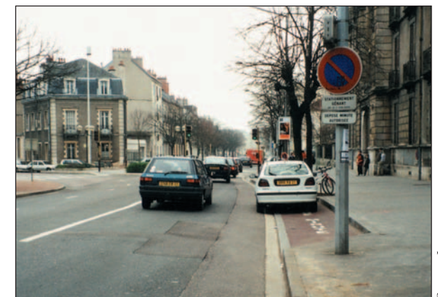
PHOTO 2 - L'arrêt minute permet aux élèves de descendre en toute sécurité directement sur le trottoir. Les manœuvres de ré-insertion dans le flot des véhicules sont plus faciles et la circulation est beaucoup moins perturbée. Une signalisation verticale accompagne l'aménagement.
