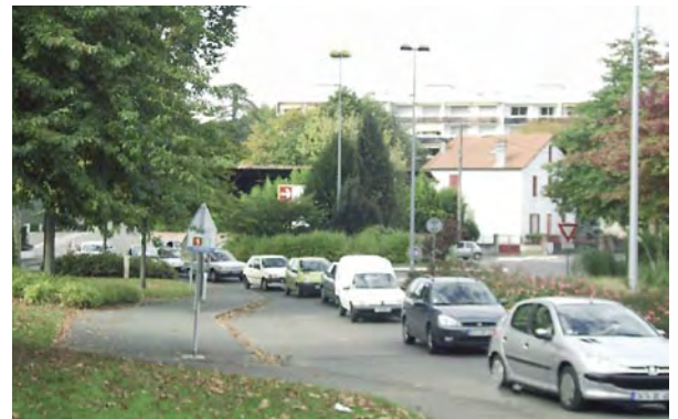
Photo 1 : P.N. 26 à Dax (source : CETE du Sud-Ouest)
