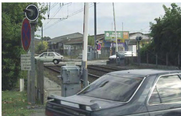
Photo 2 : P.N. 26 à Dax (source : CETE du Sud-Ouest)
