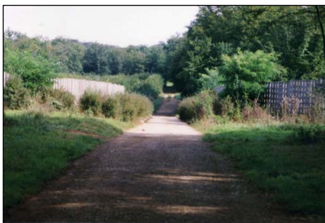
Photo 19 : Autoroute A5 (APRR) passage mixte (faune + chemin forestier) 3 années après la mise en service. Source : J. Carsignol - Cete de l'Est
