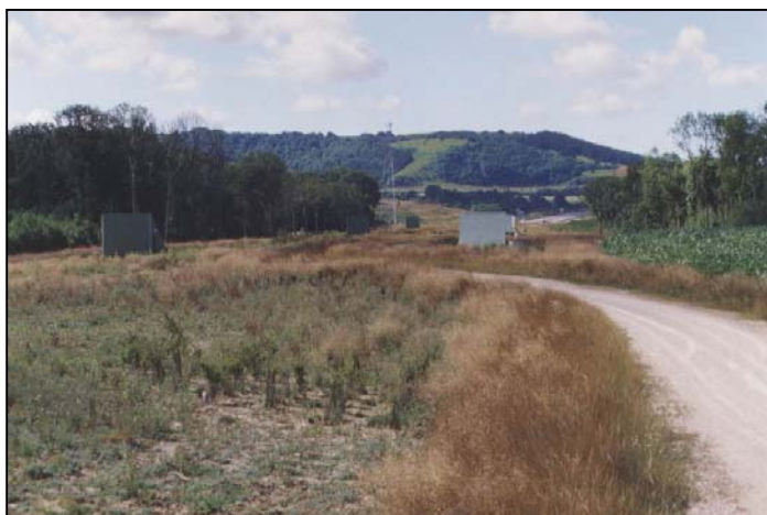
Photo 38 : Autoroute A16 (Sanef), tranchée couverte (Nord-Pas-de-Calais) – Seules les guérites de secours (en vert) indiquent la présence de l'autoroute sur la dalle plantée) Source : J. Carsignol – Cete de l'Est
