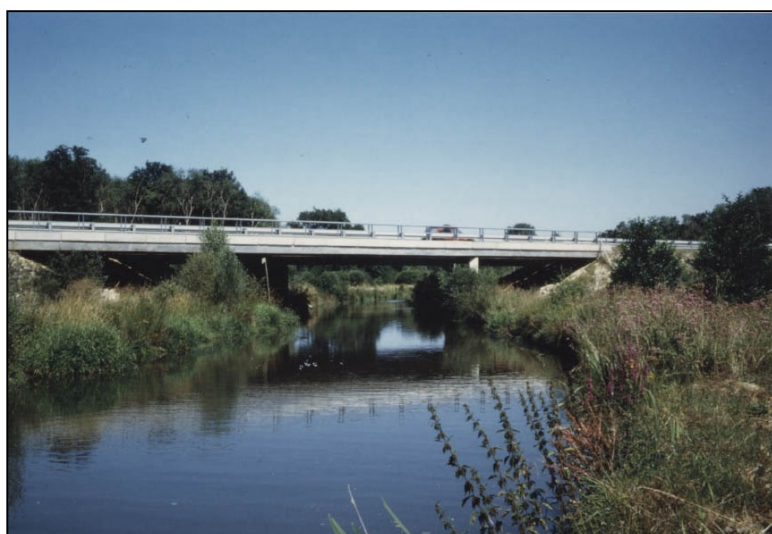
Photo 14 : Autoroute A71 (Cofiroute), passage mixte (faune + hydraulique) en Sologne Source : J. Carsignol – Cete de l'Est
