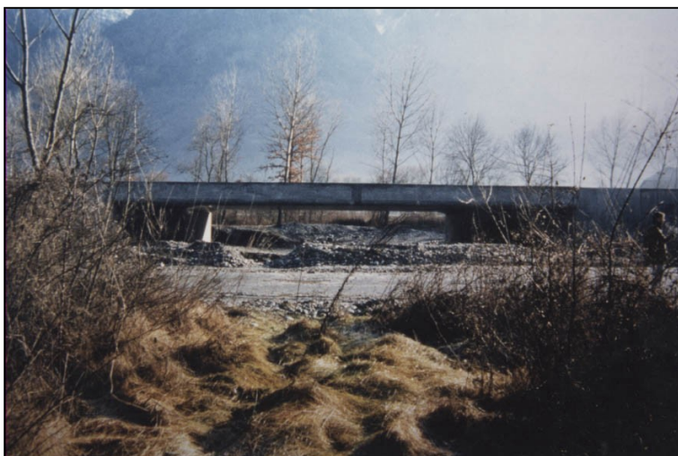
Photo 33 : Autoroute A43 (SFTRF), passage inférieur spécifique sur la vallée de la Maurienne Source : J. Carsignol – Cete de l'Est
