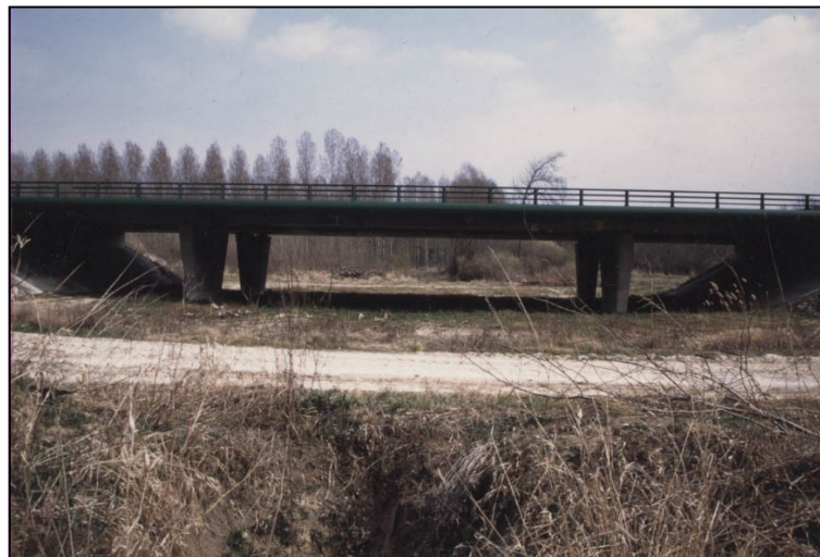
Photo 15 : Autoroute A26 (Sanef), passage hydraulique dans la vallée de l'Aube Source : J. Carsignol – Cete de l'Est
