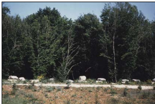
Photo 69 : Autoroute A5 (APRR), piège à empreintes (qui, en l'absence de matériels automatiques, sont des outils indispensables pour évaluer l'efficacité des passages) et obstacles aux véhicules sur l'A5 (Champagne – Ardenne) Source : J. Carsignol – Cete de l'Est
