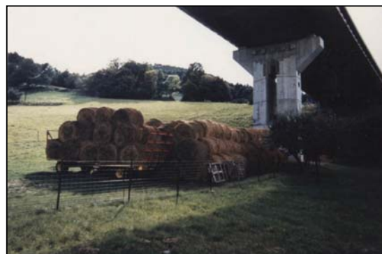
Photo 58 : RN59 ( Vosges), détournement de fonction Source : J. Carsignol – Cete de l'Est
