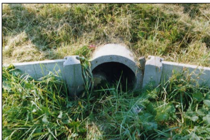
Photo 53 : RD 19 (Haut Rhin), passage pour les amphibiens à double sens Source : J. Carsignol – Cete de l'Est
