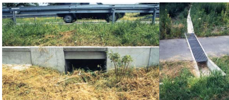
Photos 54 : Diverses réalisations en Allemagne, passages pour amphibiens et petite faune Source : J. Carsignol – Cete de l'Est
