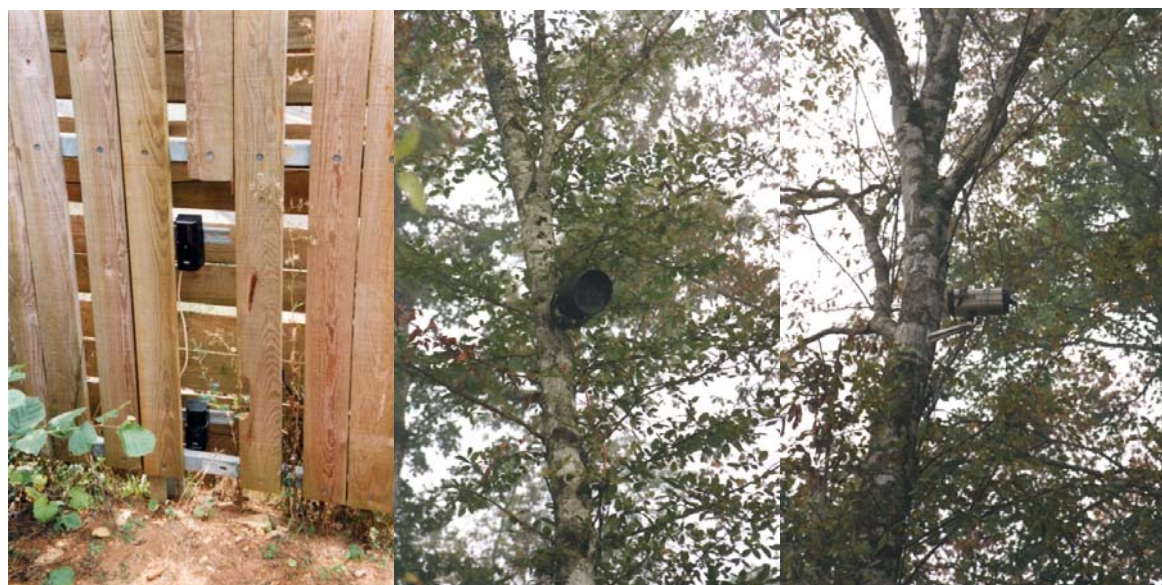
Photos 62 : Autoroute A5 (APRR), vidéosurveillance des passages sur l'A5 (Champagne – Ardenne), à gauche système de détection, au centre projecteur infra rouge, à droite caméra de surveillance Source : J. Carsignol – Cete de l'Est
