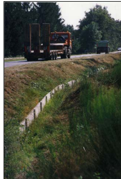
Photo 52 : RD 19 (Haut Rhin), murets préfabriqués utilisés comme dispositifs de collecte.
