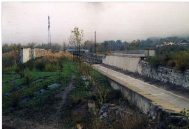
Photo 32 : Autoroute A43 (SFTRF), passage mixte (faune + pont canal) dans la Vallée de la Maurienne Source : J. Carsignol – Cete de l'Est
