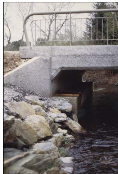
Photo 45 : RD 18 (Finistère,) passage pour la loutre équipé d'un piège à traces (cadre en bois garni de sable frais) Source : J. Carsignol – Cete de l'Est
