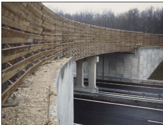
Photo 68 : Autoroute A5 (APRR), parapets d'occultation, culée en terre armée sur l'A5 (Champagne – Ardenne) Source : J. Carsignol – Cete de l'Est
