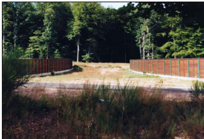
Photo 29 : Doublement de la RN 59 (Vosges), passage spécifique supérieur Source : J. Carsignol – Cete de l'Est
