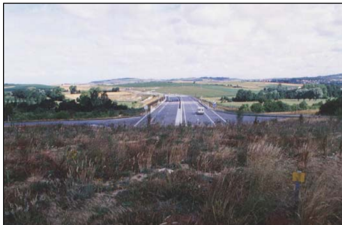
Photo 37 : Autoroute A16 (Sanef), tranchée couverte (Nord-Pas-de-Calais) Source : J. Carsignol – Cete de l'Est
