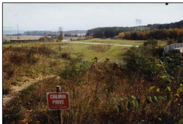
Photo 61 : LGV Nord (Ile de France), accès interdit sur la tranchée couverte Source : J. Carsignol – Cete de l'Est
