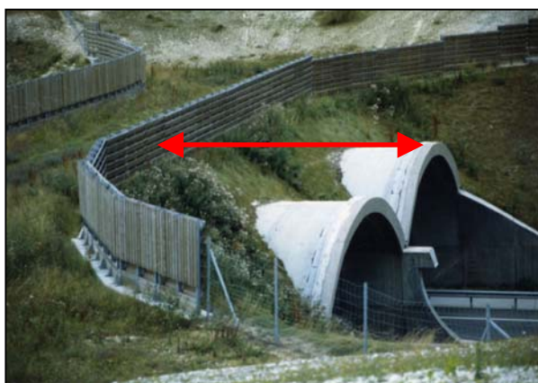
Photo 71 : Autoroute A16 (Sanef), utilisation de conduits préfabriqués (Nord-Pas-de-Calais) Source : J. Carsignol - Cete de l'Est
