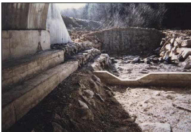
Photo 46 : Autoroute A 89 (APRR), passage pour la loutre sur l'A89 (Auvergne) : "pieds secs" à gauche de l'ouvrage Source : M. Owallier
