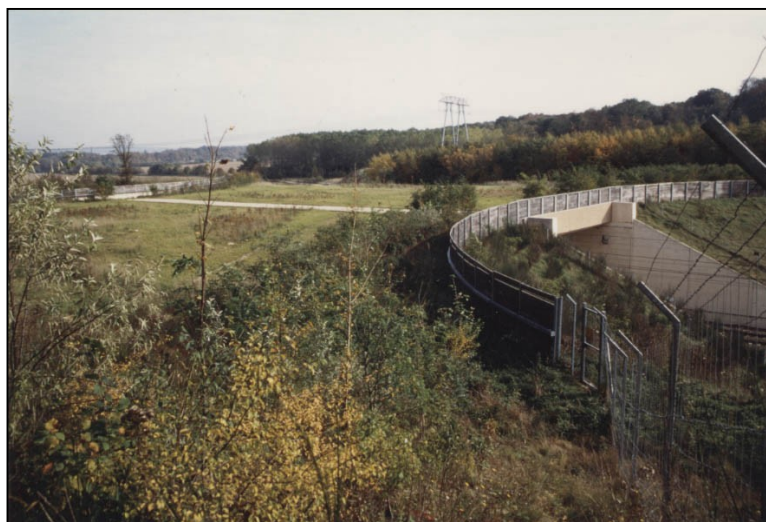
Photo 35 : TGV Nord (Ile de France), tranchée couverte de 80 m de large Source : J. Carsignol – Cete de l'Est
