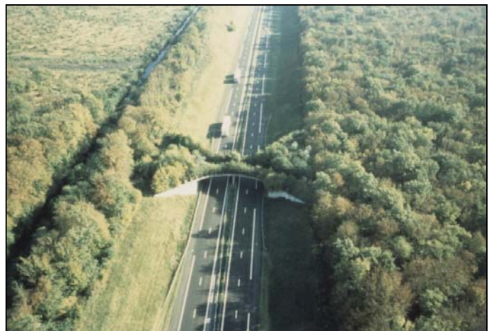
Photo 26 : Autoroute A36 (Haut Rhin), passage en diabolos Source : J. Carsignol – Cete de l'Est
