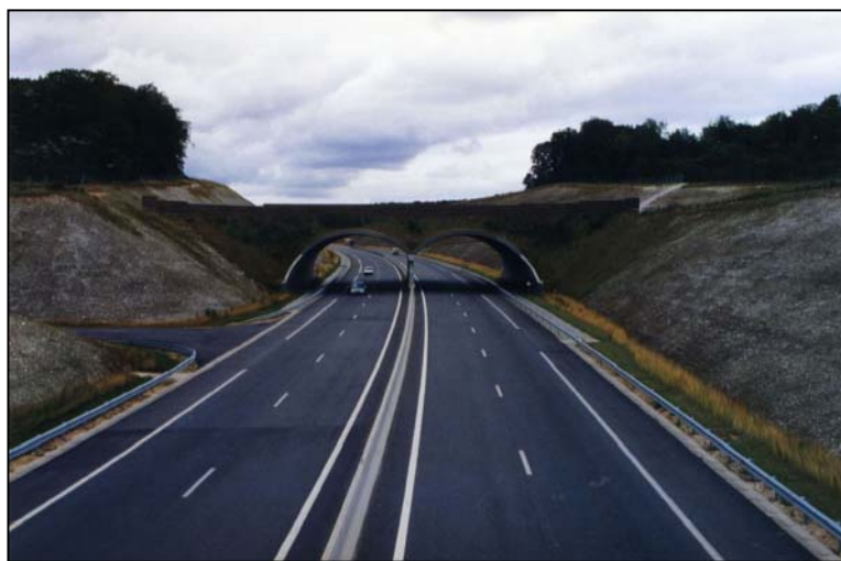
Photo 70 : Autoroute A16 (Sanef), utilisation de conduits préfabriqués (Nord-Pas-de-Calais) Source : J. Carsignol - Cete de l'Est
