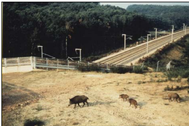
Photo 28 : TGV Atlantique, passage spécifique supérieur Source : SNCF
