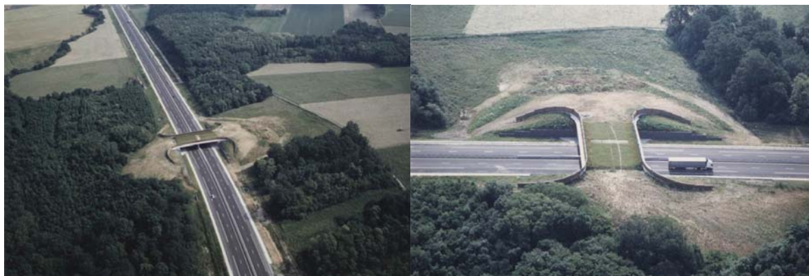
Photos 30 et 31 : VRPV (Bas Rhin) écopont de 20 m de large implanté au-dessus de la voie Source : J. Carsignol – Cete de l'Est
