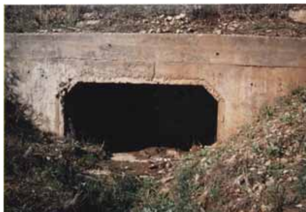
Photo 48 : Autoroute A57 (ESCOTA) (Côte d'Azur), dalots pour les tortues Source : J. Carsignol – Cete de l'Est
