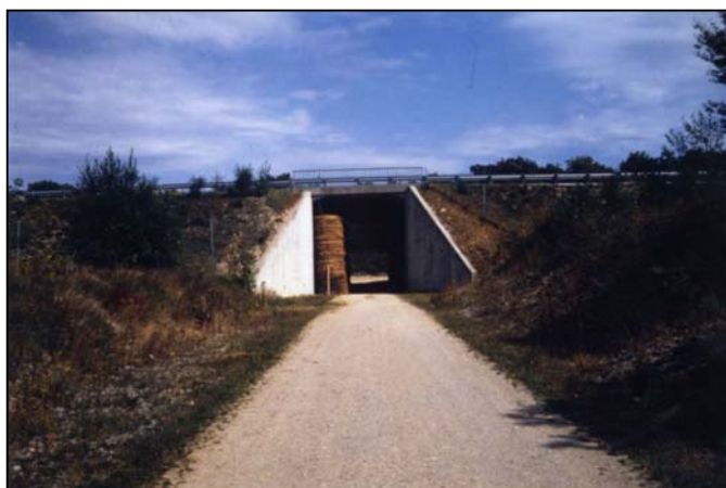
Photo 57 : Autoroute A 31 (APRR), détournement de fonction de ce passage (Lorraine) Source : J. Carsignol – Cete de l'Est
