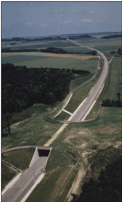
Photo 34 : TGV Nord (Ile de France), tranchée couverte de 80 m de large Source : SNCF – CAV – P. Olivain
