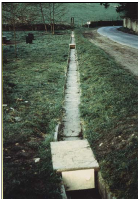
(Moselle), caniveau en U pour la capture, fosses de traversée protégée Source : J. Carsignol – Cete de l'Est
