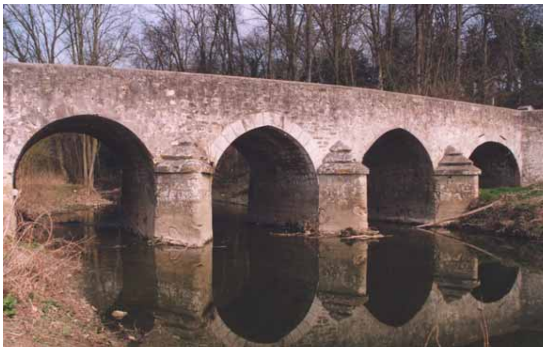
Pont en maçonnerie à Yerres (91).
