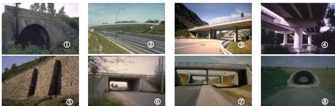
① Pont en maçonnerie, Setra/Mayenne ② Passerelle piétons en métal, Setra/Haute-Garonne ③ Passage supérieur en dalle précontrainte, Setra/Alpes-de-Haute-Provence ④ Viaduc, Setra/Seine-et-Marne ⑤ Mur de soutènement, Setra/Pyrénées-Orientales ⑥ Passage inférieur en portique ouvert, Le Khac V. ⑦ Portique ouvert double, Le Khac V. ⑧ Buse, Setra.
