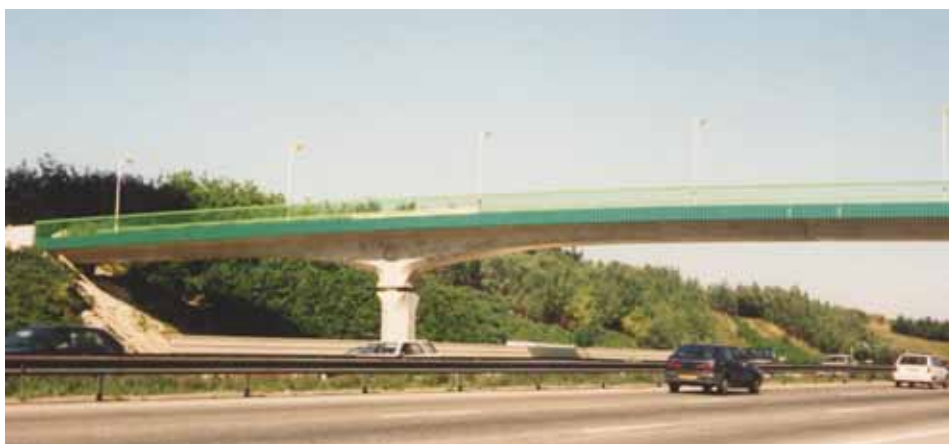
Passerelle au-dessus de l'autoroute A4, Noisy le Grand.
