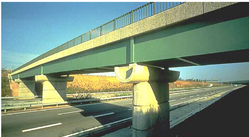
Pont mixte sur l'A55, entre Arles et Nîmes. Source : Raoul J.
