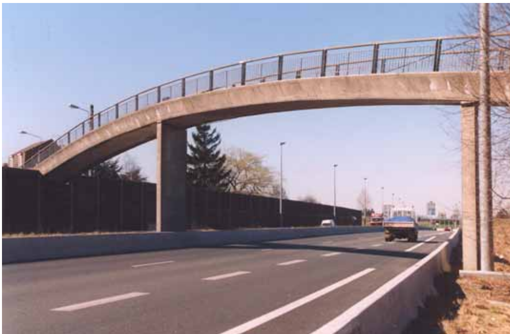
Passerelle sur l'autoroute Lille-Gant
