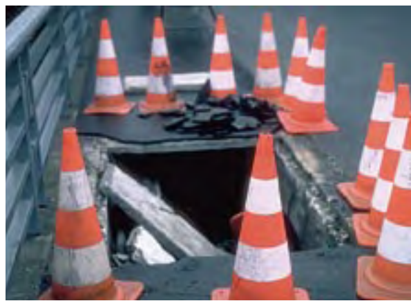
b) Effondrement de dallettes suite à un passage intempestif d'un véhicule.
