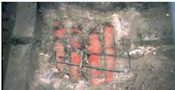
Figure 27 : Encombrement, faible épaisseur du béton de couverture des tuyaux, pas de ferrailage, etc. constituent trop souvent le lot de l'aménagement de cette partie d'ouvrage. L'aménagement de la photo de droite paraît mieux étudié.
