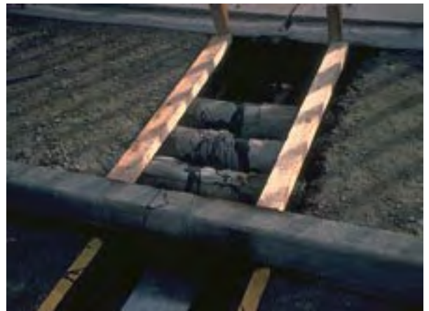
Noter le coffrage des bords calorifugeage des canalisations en PVC.
