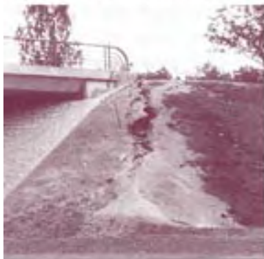
Figure 16 - Evacuation des eaux aux extrémités de l'ouvrage
