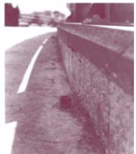
Figure 19 : Tube mis en place lors du bétonnage de la dalle
