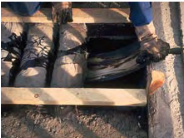
Mise en place de la plaque de pontage.
