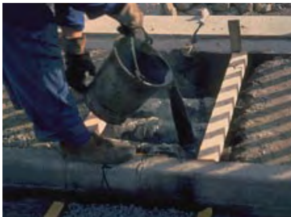
Coulage du liant.
