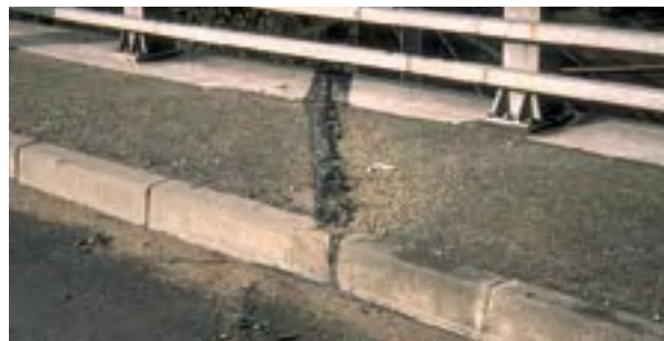
Figure 26 : Exemples, à gauche, d'un ensemble homogène et à droite, d'un ensemble hétérogène : le souffle dans le joint entre bordure de trottoir est insuffisant et on risque une mise en butée des bordures. Sur trottoir, le joint n'a pas la capacité de souffle requise.
