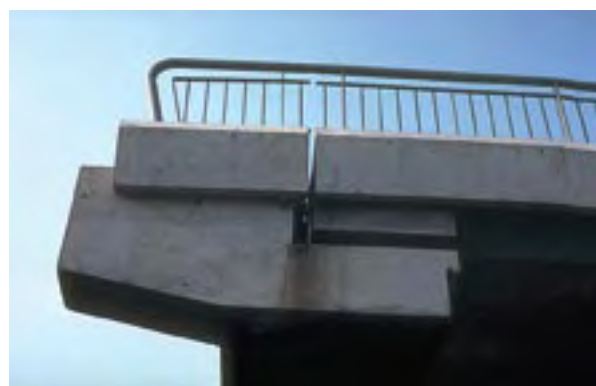
Figure 32 : Conséquences de l'absence d'un joint dans la corniche. La conception de cette zone avec deux montants de garde-corps scellés aussi près du vide (les frettes du scellement font-elles bien le tour du poteau ?!) rend la mise en place d'un joint quasi impossible.
