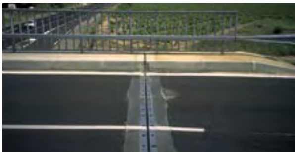
Figure 26 : Exemples, à gauche, d'un ensemble homogène et à droite, d'un ensemble hétérogène : le souffle dans le joint entre bordure de trottoir est insuffisant et on risque une mise en butée des bordures. Sur trottoir, le joint n'a pas la capacité de souffle requise.
