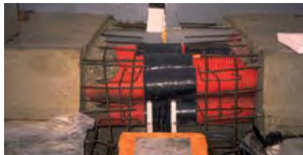
Figure 27 : Encombrement, faible épaisseur du béton de couverture des tuyaux, pas de ferrailage, etc. constituent trop souvent le lot de l'aménagement de cette partie d'ouvrage. L'aménagement de la photo de droite paraît mieux étudié.
