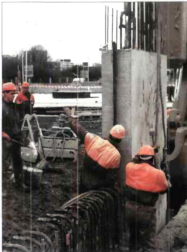
Figure 3.8 EXÉCUTION D'UNE PAROI PRÉFABRIQUÉE – DESCENTE D'UN PANNEAU DANS L'EXCAVATION
