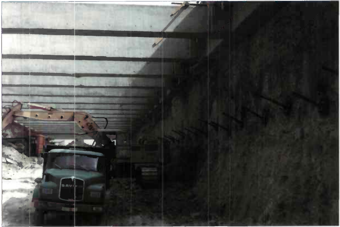
Figure 3.7 PAROIS MOULÉES BUTONNÉES EN TÊTE
