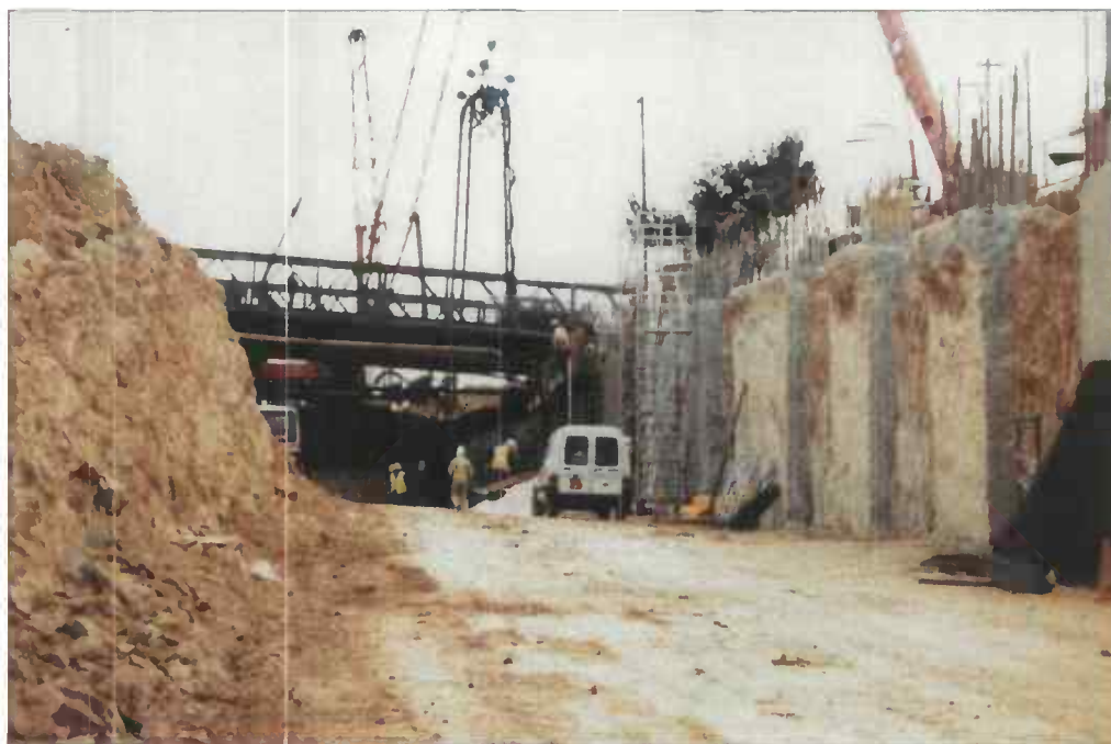
Figure 3.26 PORTIQUE SUR PIÉDROITS DE BARRETTES : RÉALISATION
