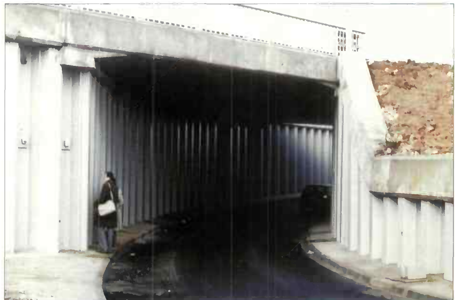
Figure 1.5 VISIBILITÉ LATÉRALE DANS UN OUVRAGE EN COURBE
