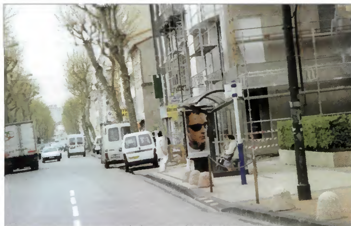
Valence, arrêt Ferdinand Pié, ligne 1, les plots sur la zone d'attente sont particulièrement gênants (source : IDF Conseil)
