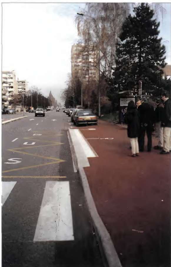
Mâcon, ligne 4, l'avancée du point d'arrêt couvre correctement le stationnement (source CERTU)
