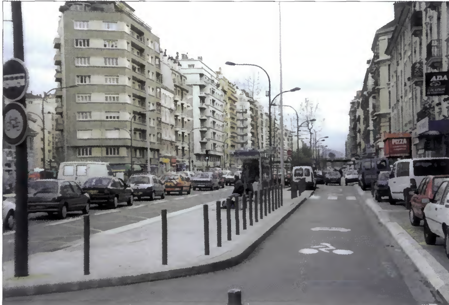
Un exemple d'un point d'arrêt avec contre-allée : Grenoble, ligne 1, arrêt l'Aigle (source : IDF Conseil)
