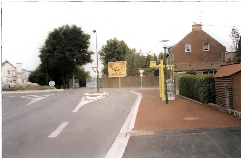
Dauai, l'arrêt Pant Vincourt, ligne 21, aménagé à proximité d'un giratoire en amant avec by-pass (source : IDF Conseil)
