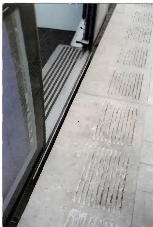
Le comble-lacune du tramway de Montpellier et la bande tactile choisie qui annonce le bord des quais (source : CERTU)
