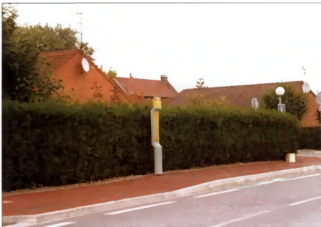
Exemple d'emplacement d'un poteau d'arrêt, en tête de quai et en retrait notable du bord du trottoir, Dauai, arrêt Gadian, ligne 81 (source : IDF Conseil)
