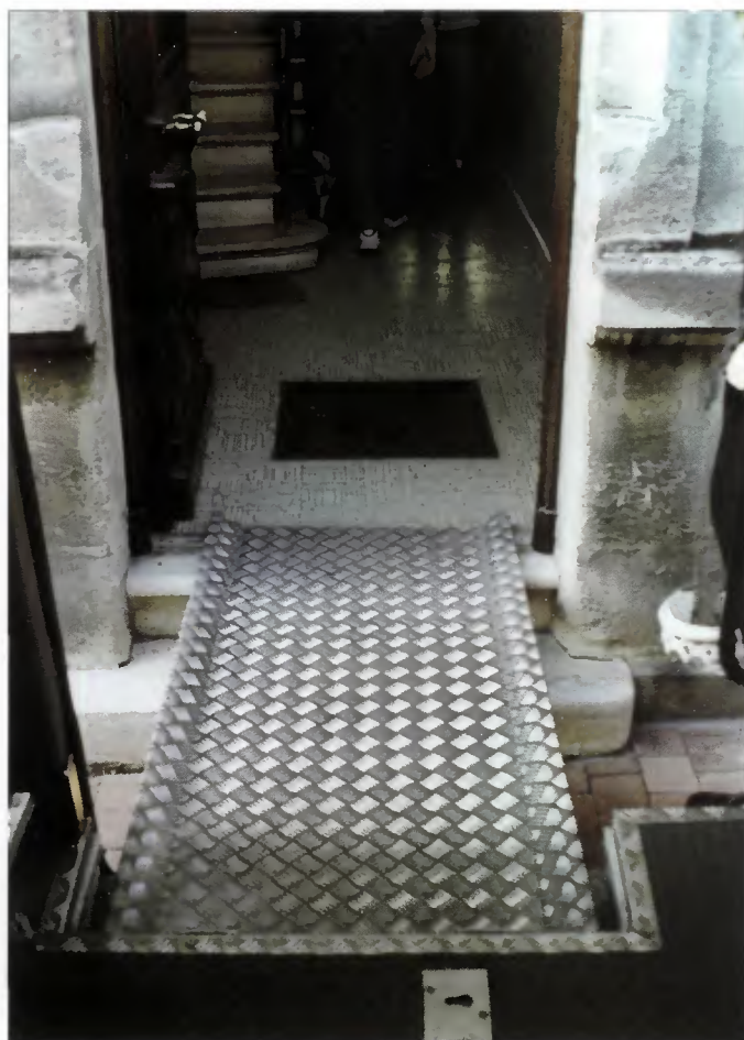
Pose de polette spécifique pour un service «porte-à-porte», service Transodopt à Bordeaux (source: CERTU)
