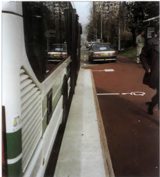
La qualité de l'accostage d'un Agora line du SITUM, Mâcon, ligne 4 (source : CERTU)
