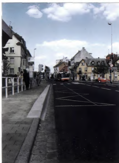
Figure 7: exemple de guidage visuel par ligne peinte au sol – réseau de Strosbourg
