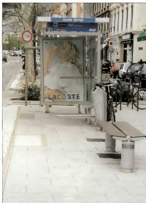
Exemple de matérialisation de la zone d'attente pour l'utilisateur de fauteuil roulant, face à la porte du milieu Grenoble, arrêt Jaurès-Berriot, ligne 1 (source: IDF Conseil)
