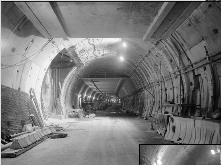
Exemple de dalle de plafond à l'intérieur d'un tunnel creusé au tunnelier (Tunnel de Caluire)
