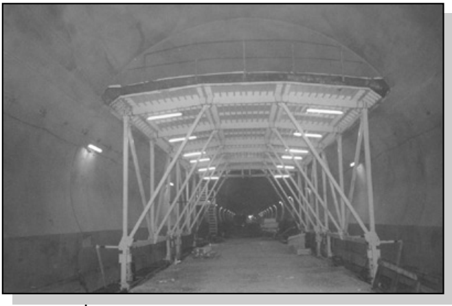
Coffrage de dalle de plafond
