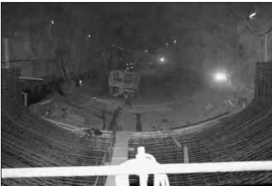
Armatures de radier
