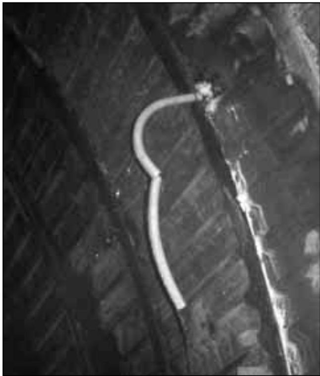
Exemple de captage des venues d'eau en phase de construction
