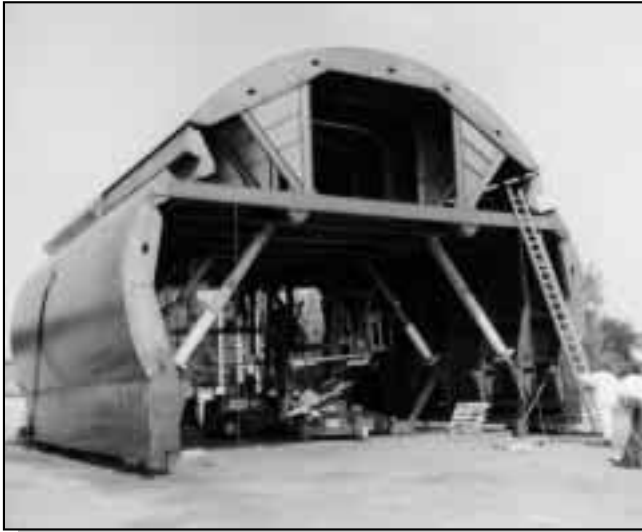
▲ Fig. 3.1 - Coffrage de tunnel
