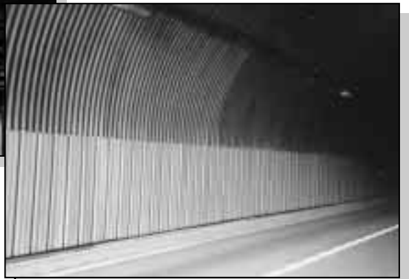
Habillage par bardage et parapluie en tôles
