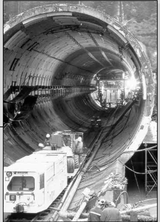
Exemple de revêtement par voussoirs en béton
