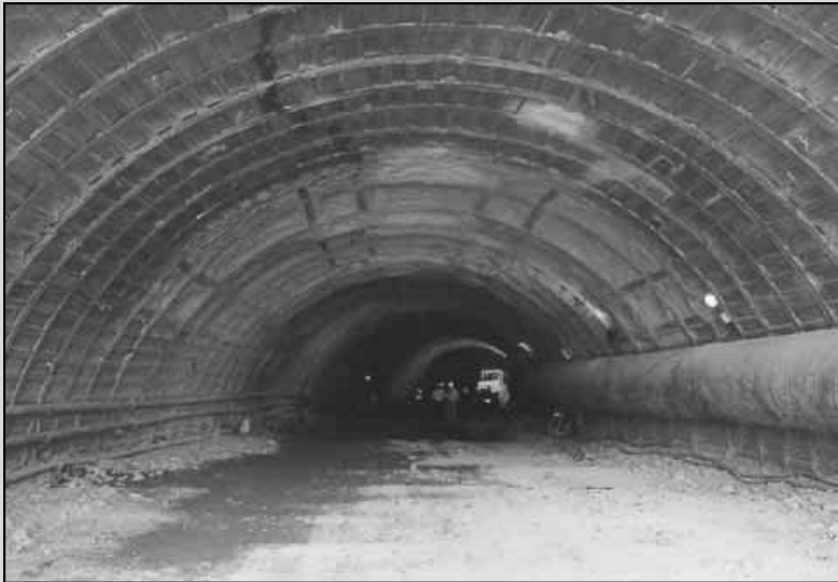
Profil de soutènement avec cintres lourds
