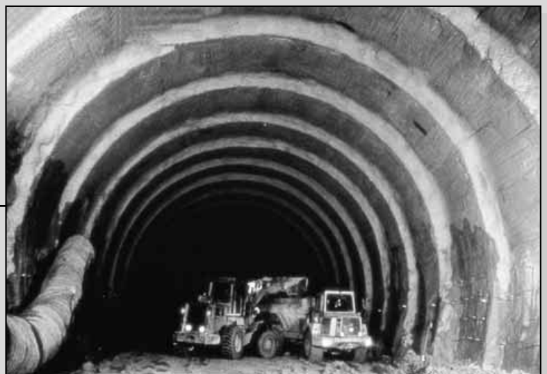
Exemple de soutènement par prédécoupage (LA GALAURE)
