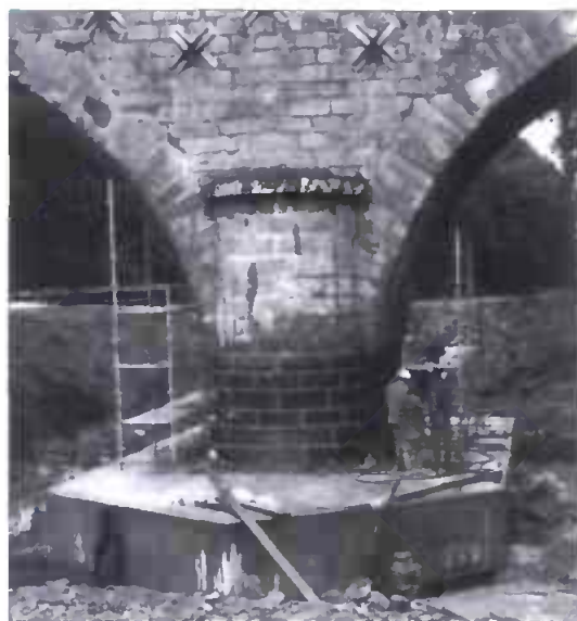
Travaux de confortement de la pile du pont du Nia d'Oie à Clisson.
