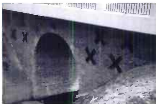
Pont de Bourg à Mouzillon (dépt. 44) après réparation.
