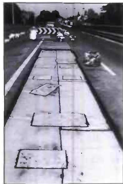
Réfection locale d'une chape.
